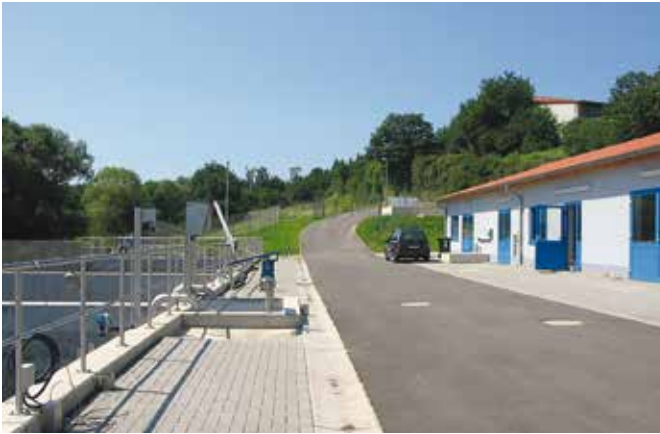
Kläranlage in Kriegsfield
