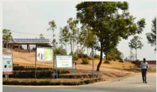
Weitsicht auf die neu installierte Solaranlage des handwerklichen Ausbildungszentrums für benachteiligte Jugendliche in Muhanga (Foto: TFG-Rwandaprojekt).
