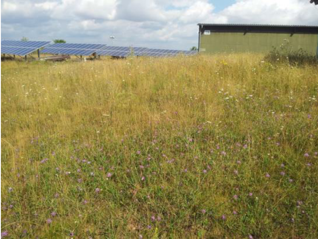
Ehemalige Militärstation am Hagelkreuz östlich von Quirnheim: Sie wird als Photovoltaikstation genutzt.
