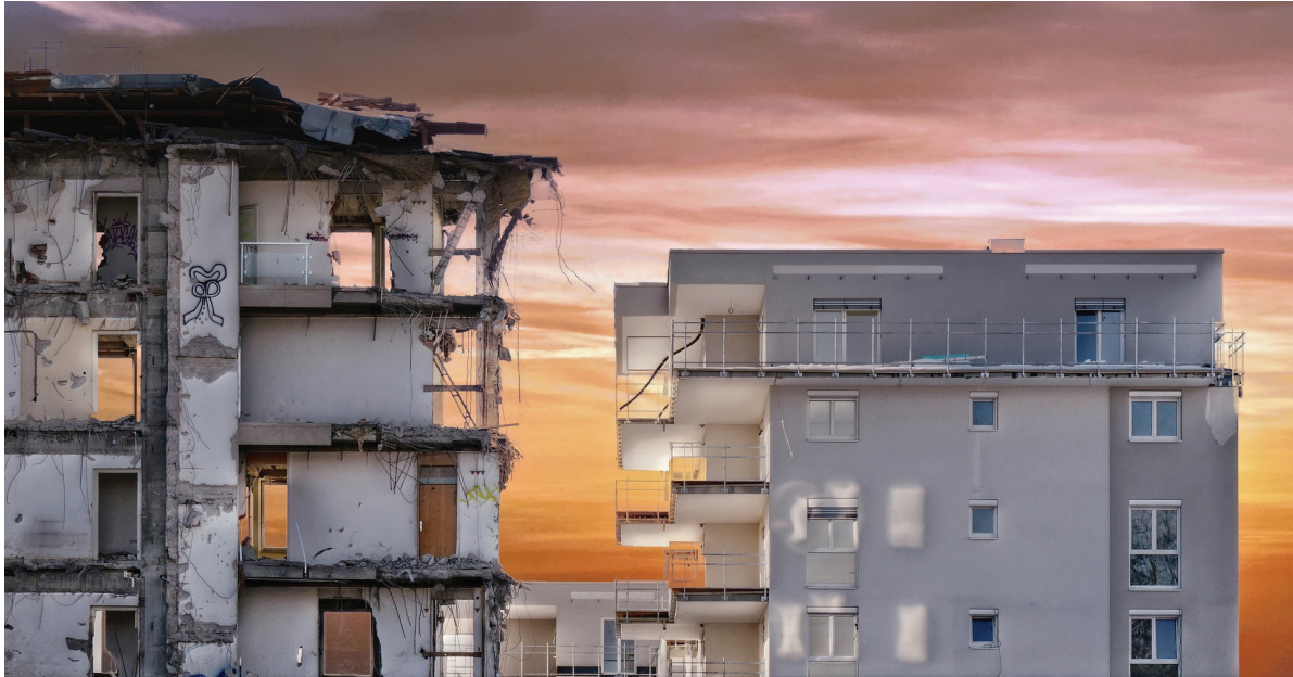
Abb. 10: Gebäuderückbau, Start des Recyclings; Quelle: Pixabay
