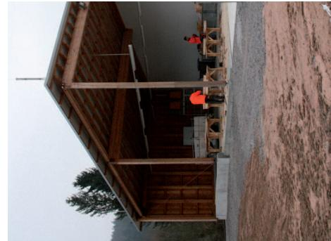
Der Dachaufbau besteht ebenfalls aus vorgefertigten Holzdachträgern. Zwischen den thermisch getrennten Sparren ist eine Einblaszellulose von circa 400 Millimetern Dicke vorhanden. Für die Dachdeckung wurden Sandwichelemente aus Trapezprofilen mit einer Kerndämmung von 30 Millimetern gewählt.
