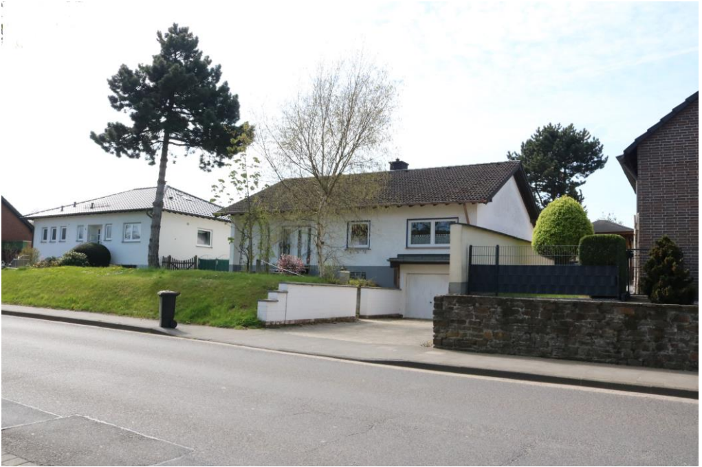
Neuenahrer Straße 6 (links) und 4 (rechts). Rohbau-Abnahme von Nr. 4 am 31. März 1977. 302 Baugenehmigung zum Neubau des Wohnhauses Neuenahrer Straße 6 am 2. März 1978. 303 Foto vom 16. April 2019.
