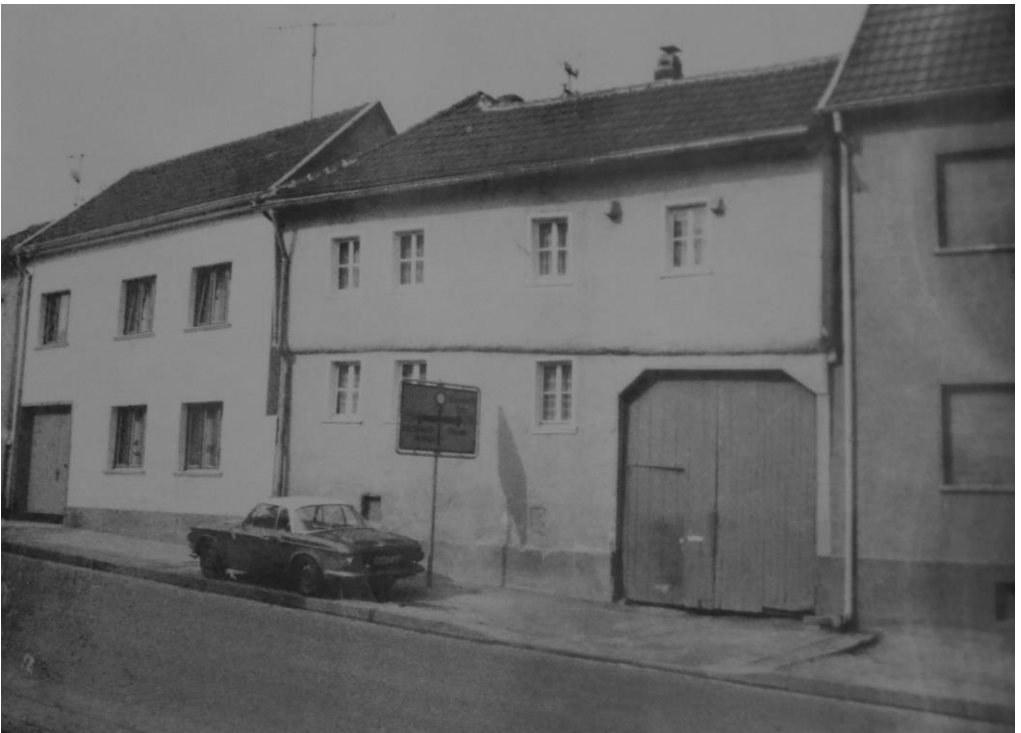
Aufnahme als Anlage zum Bauantrag von 1975. Die Genehmigung zur Erneuerung der Fachwerk-Fassade am Haus Bonner Straße 19 wurde erteilt. 126
