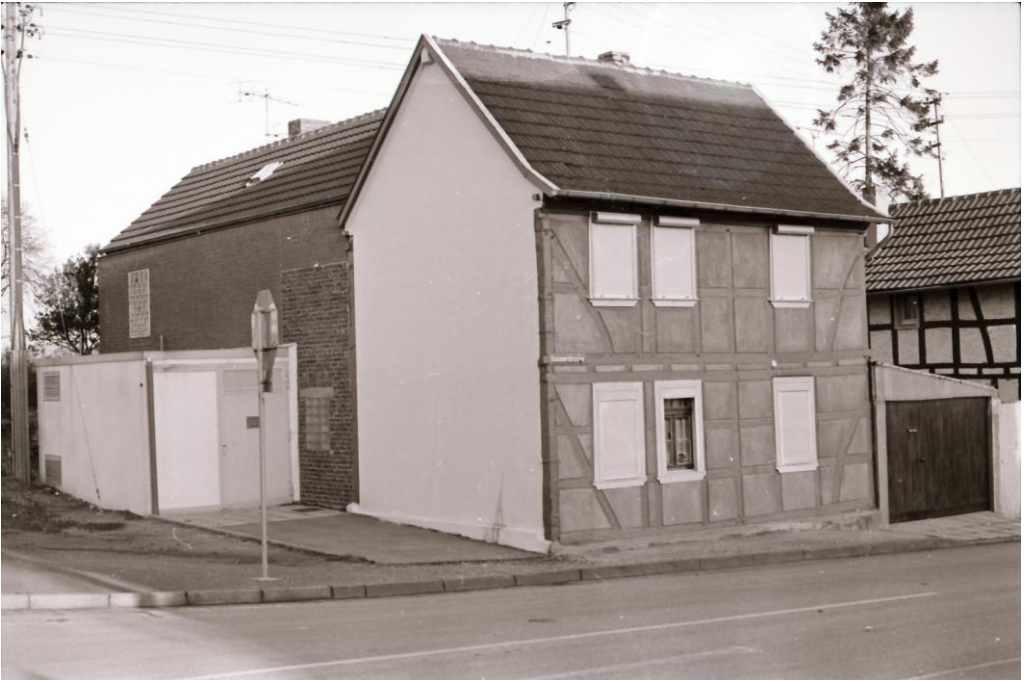
Foto vom 19. Januar 1975, links eine 1970 errichtete Transformatorstation 120
