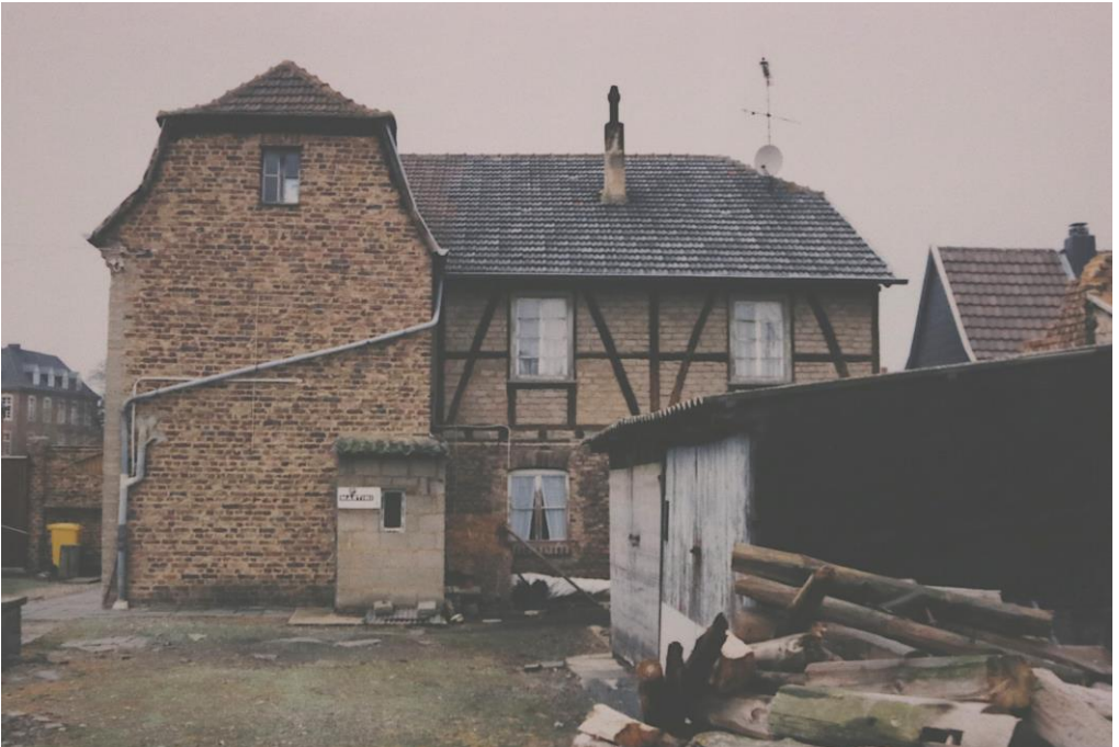
Hofseite des Wohnhauses 1996, kurz vor dem Abbruch
