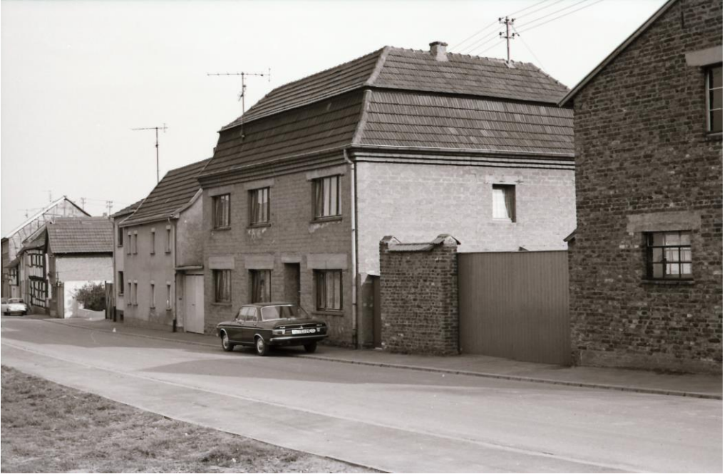
Bauernhof Linden. Das rechtsstehende Ziegelsteingebäude war der zugehörige Stall, Aufnahme vom 2. März 1975.
