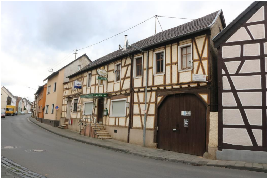
1966 Erneuerung der Außentreppe, die zu Gunsten des Bürgersteigs auf einen Meter verringert wurde. 181 1994 Anbringung einer Werbetafel "Zur Tant". 182
