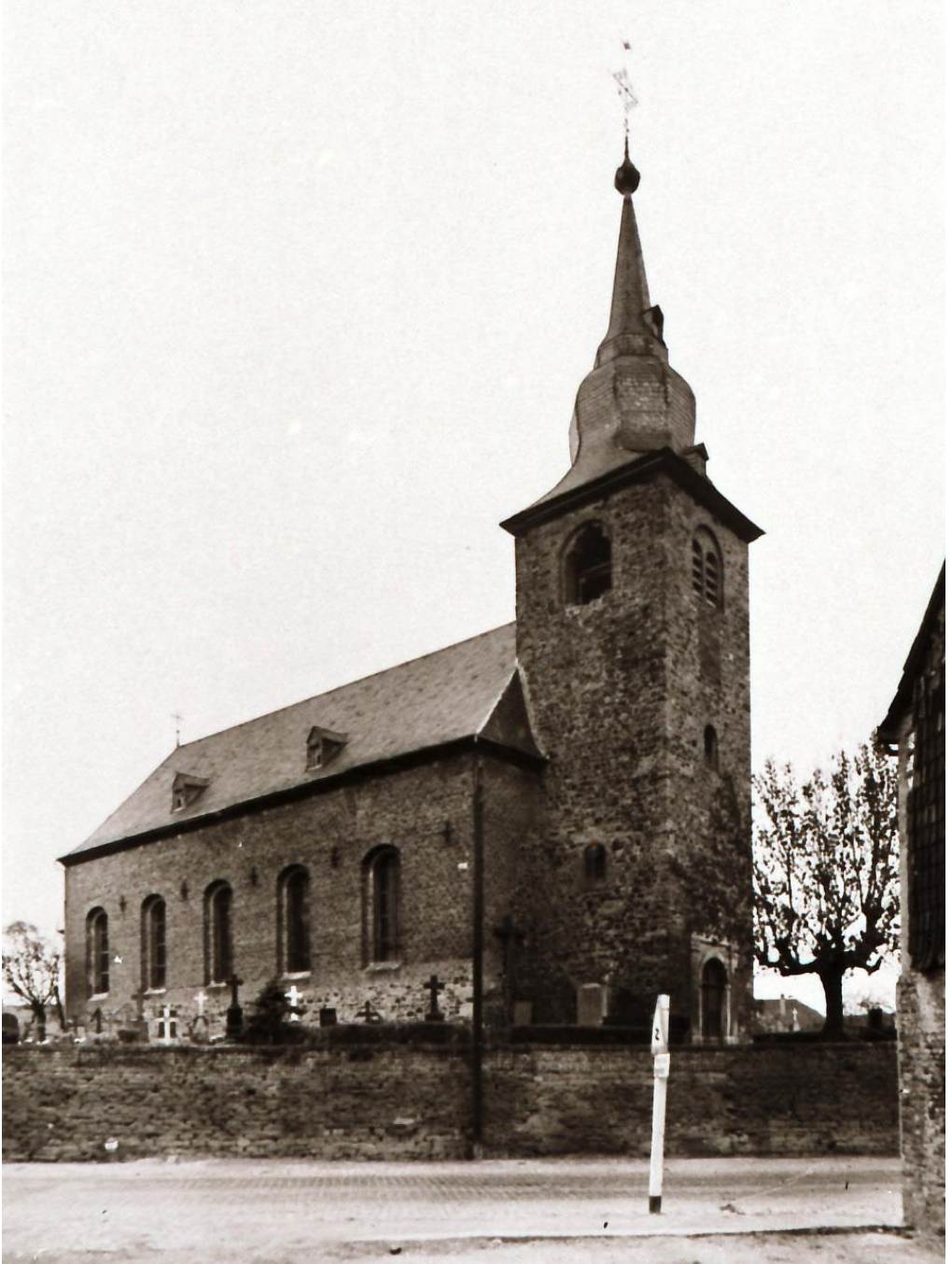
Zustand der Kirche vor 1962
