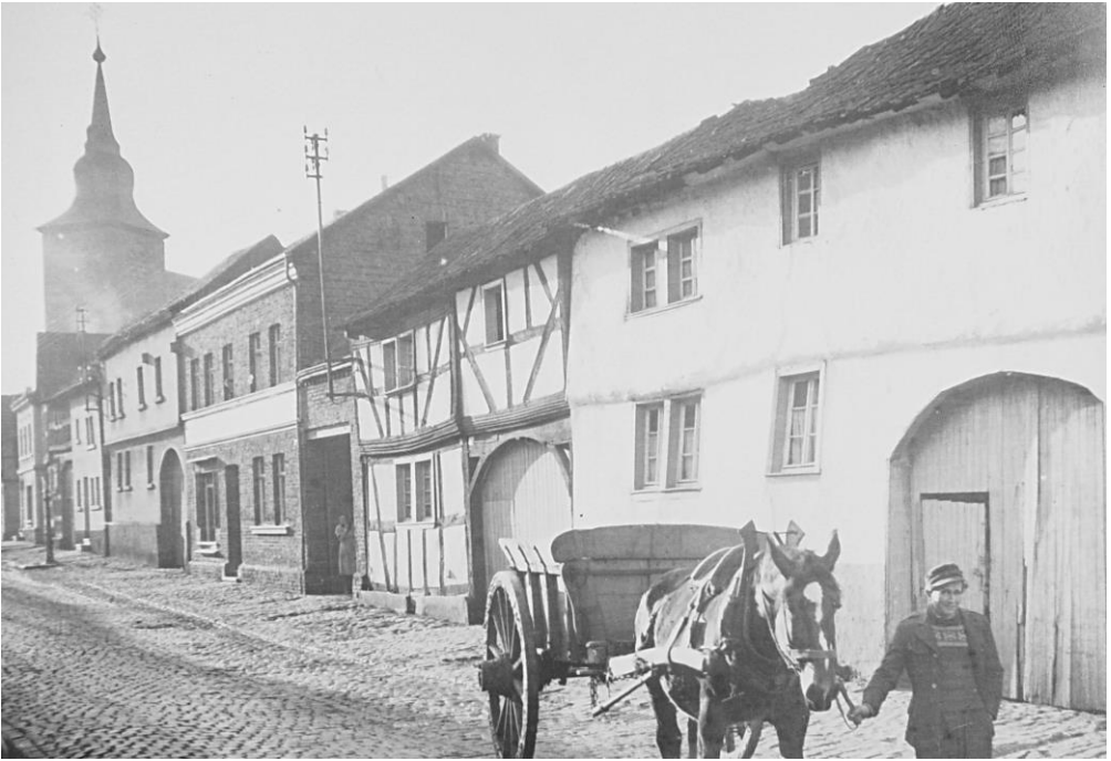
Bonner Straße 57 (Backsteinbau hinten), 59 (Fachwerkfassade) und 61 (Fachwerkbau mit Lehmputz), wohl in den 1950er Jahren.
