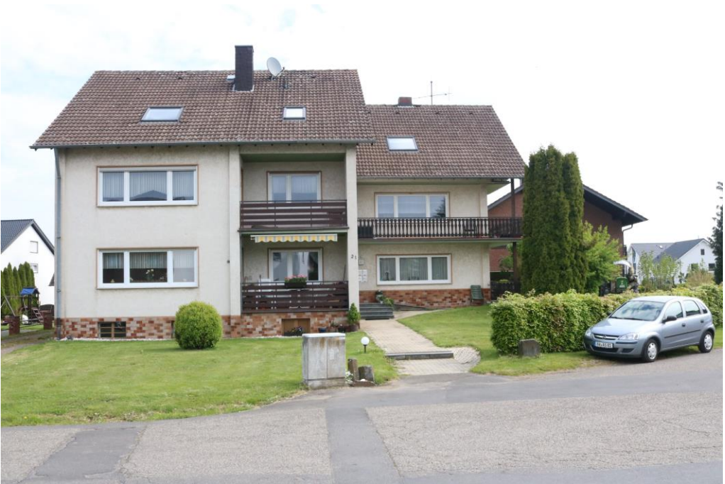
Nach dem Abbruch des alten Bauernhofes entstand ein Mehrfamilienhaus. Die Rohbauabnahme wurde am 30. Januar 1975 beantragt. 280 Foto am 18. Mai 2015.
