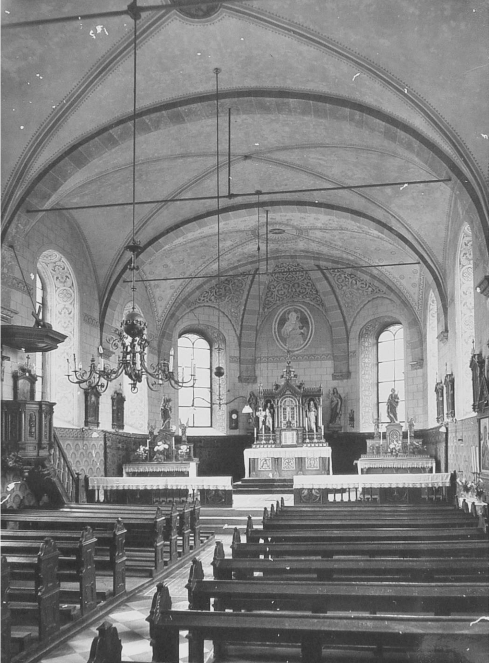
Inneres der Kirche vor der Renovierung 1962/63
