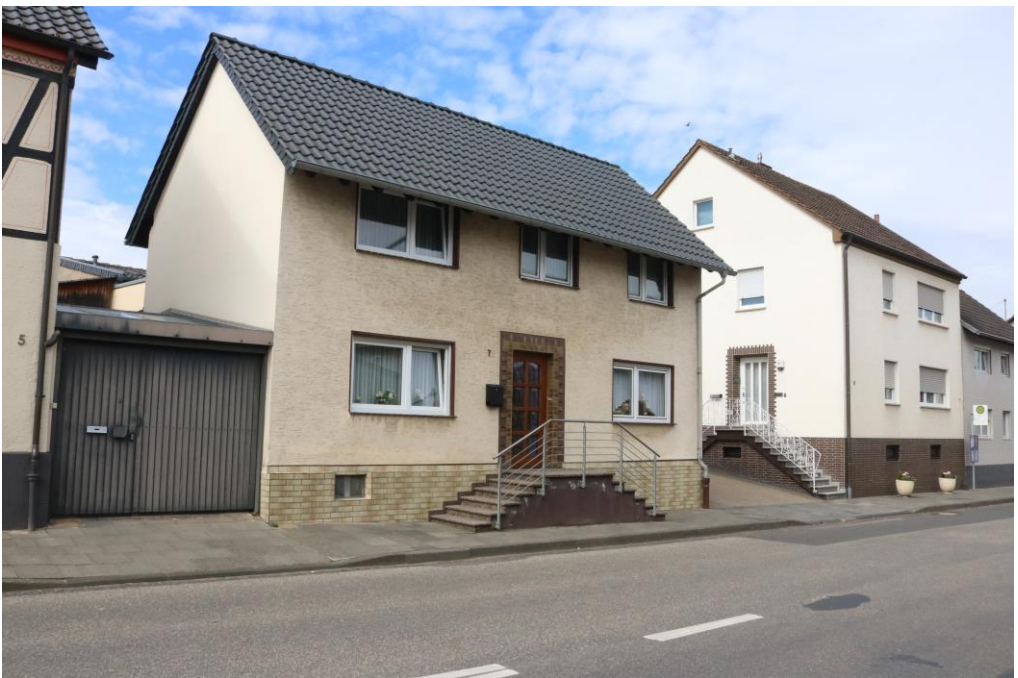
Zustand der beiden Häuser am 16. Mai 2015. Im Jahre 1979 war am Haus Dürener Straße 7 eine Erneuerung der aus Fachwerk bestehenden Außenwände durch massives Mauerwerk erfolgt. 254
