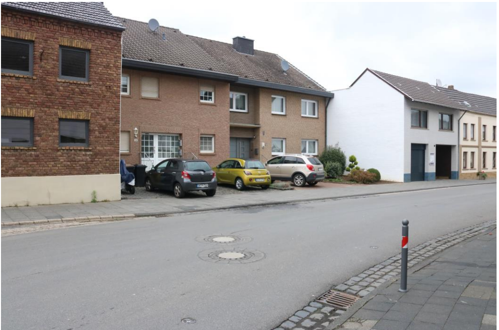
Die beiden zurückliegenden Häuser Bonner Straße 85 und 87 am 5. Oktober 2019. Der Neubau Nr. 87 wurde im Jahre 1982 vollendet. Die Baugenehmigung zum Neubau des Hauses Nr. 85 wurde am 7. Oktober 1991 erteilt. 192
