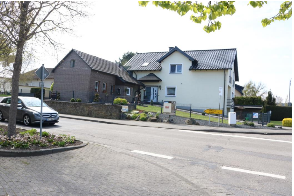
Haus Neuenahrer Straße 2 (links) und der Neubau Altenahrer Straße 1a, Rohbauabnahme 12. Mai 1978. 301 Das Foto datiert vom 16. April 2019.
