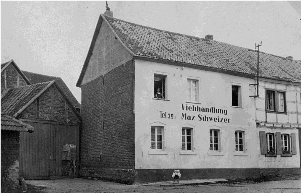
Das Haus der jüdischen Familie Schweizer (Eckendorfer Straße 3) nach der Renovierung. Foto vielleicht Ende des 1920er Jahre. Die Familie floh 1937/38 nach England. Das Haus verkaufte sie kurz vor der Abreise an Gottfried Bollig. 274
