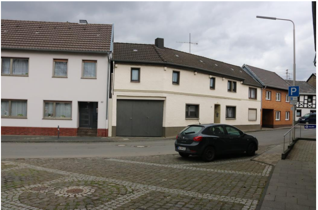
Bonner Straße 82 (links) und 80 am 3. April 2019
