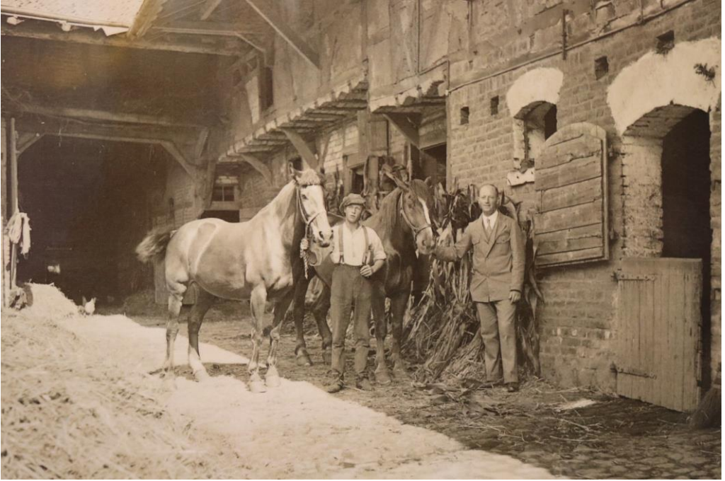
Innenhof von Haus Burgstraße 4, vor 1927
