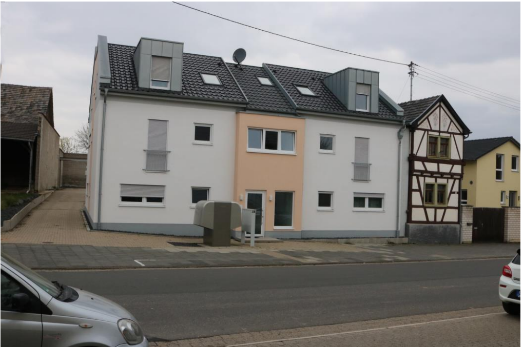
Neubau des Hauses Bonner Straße 25, Aufnahme am 12. April 2019
