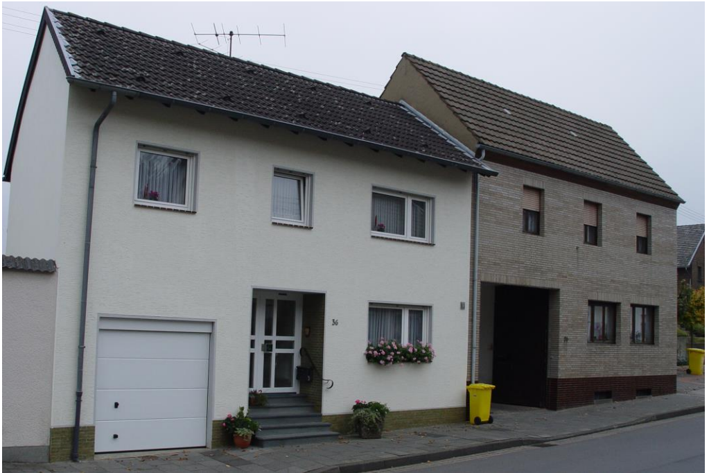
Oben von links die Häuser 36, 34 und 30 (Kindergarten) im Zustand vom 19. Januar 1975. Unten die Häuser 36 (links) und 34 am 25. Oktober 2007. Umbau am Haus 36 von Wohnraum zur Garage im Jahre 1999. 140
