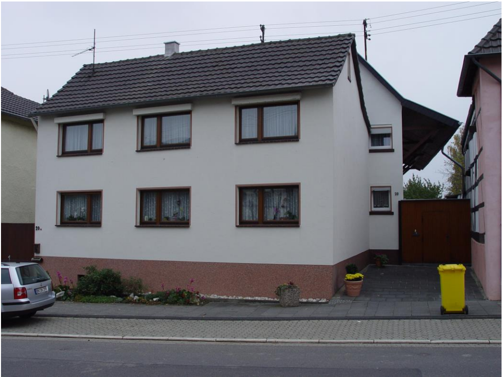
Haus Bonner Straße 20a steht an der Straße, Nr. 20 dahinter, Aufnahme am 25. Oktober 2007
