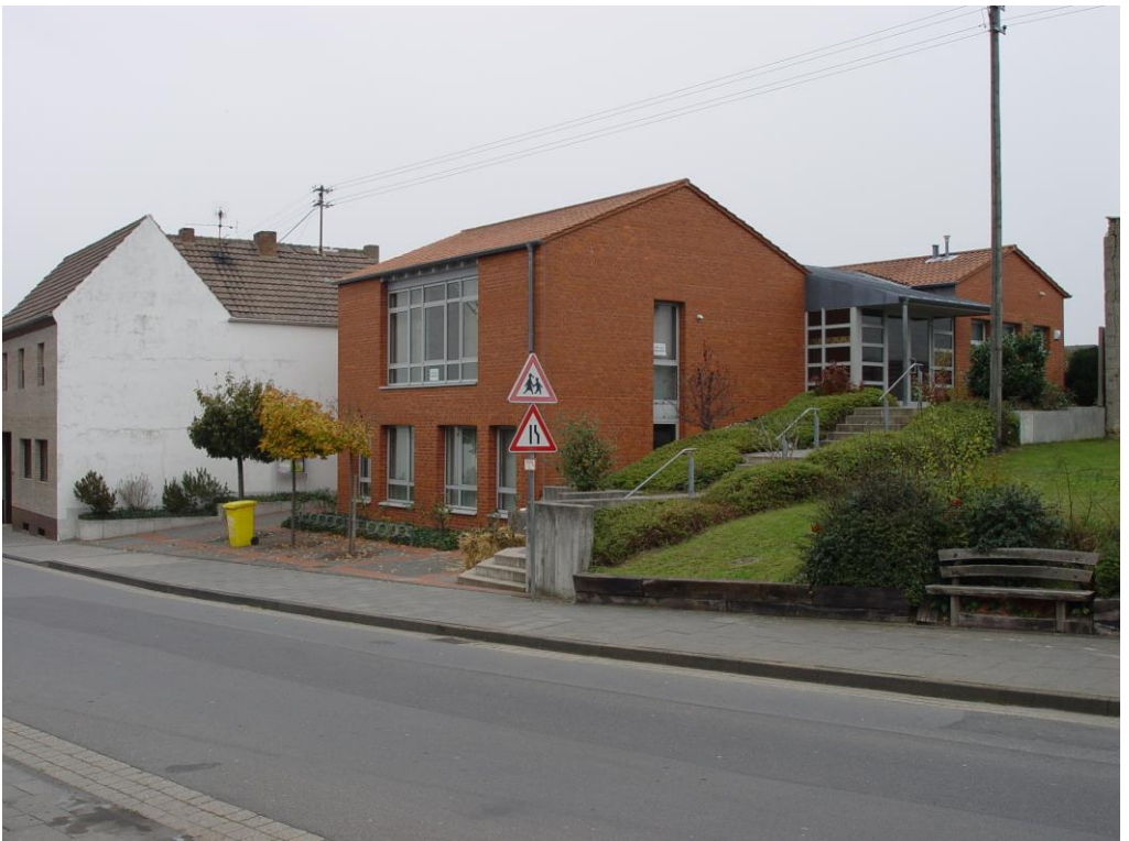
Neues Pfarr- und Jugendheim. Inbetriebnahme am 27. Juni 1992. 137 Beide Aufnahmen am 25. Oktober 2007
