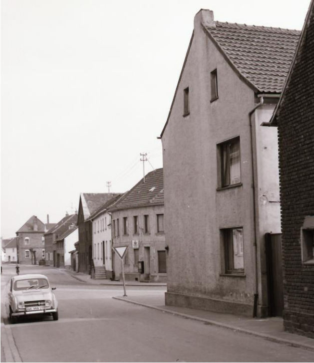
Burgstraße 1, Zustand 1975 1958 wurde eine Baugenehmigung erteilt zur Vergrößerung der Fenster und Anbringen eines Außenputzes. 206
