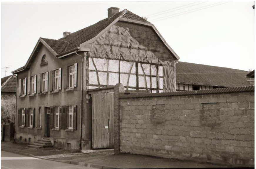
1970 erhielt Hildegard Schumacher die Erlaubnis, das auf der rechten Seite des Grundstücks stehende Gesindehaus abzureißen und den entstandenen Hofraum zur Straße hin mit einer Mauer einzufriedigen. Am 8. Dezember 1972 war das Bauvorhaben bereits ausgeführt. 152 Das Foto vom 19. Januar 1975 zeigt diese Mauer.
