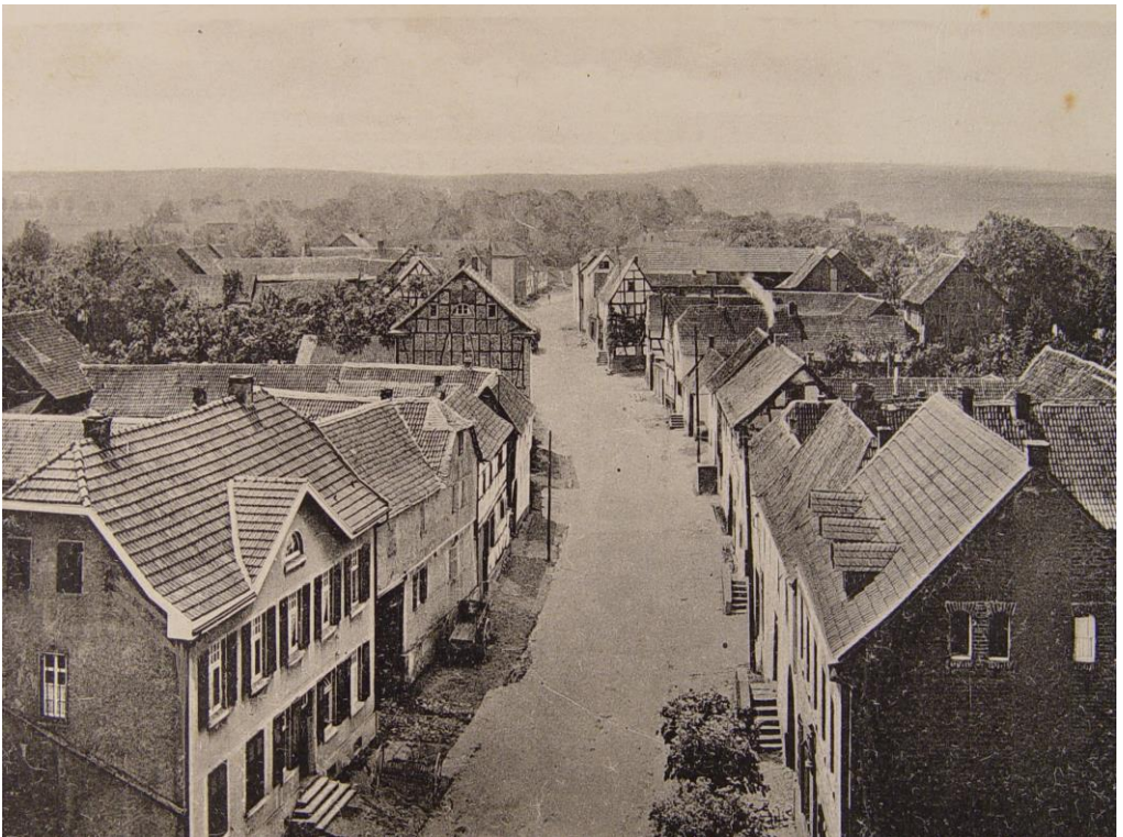
Blick vom Kirchturm in den oberen Teil der Bonner Straße, wohl 1930er Jahre
