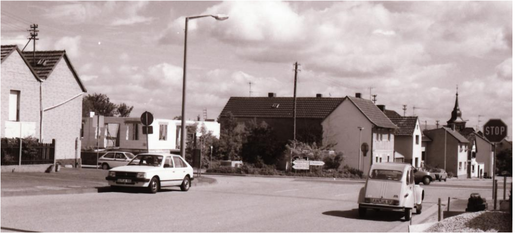
Das im Bau befindliche Haus Dürener Straße 4 (hinten links) am 3. Juli 1988. Die notwendige Baugenehmigung hatte Erwin Bär am 27. Januar 1988 erhalten. 250
