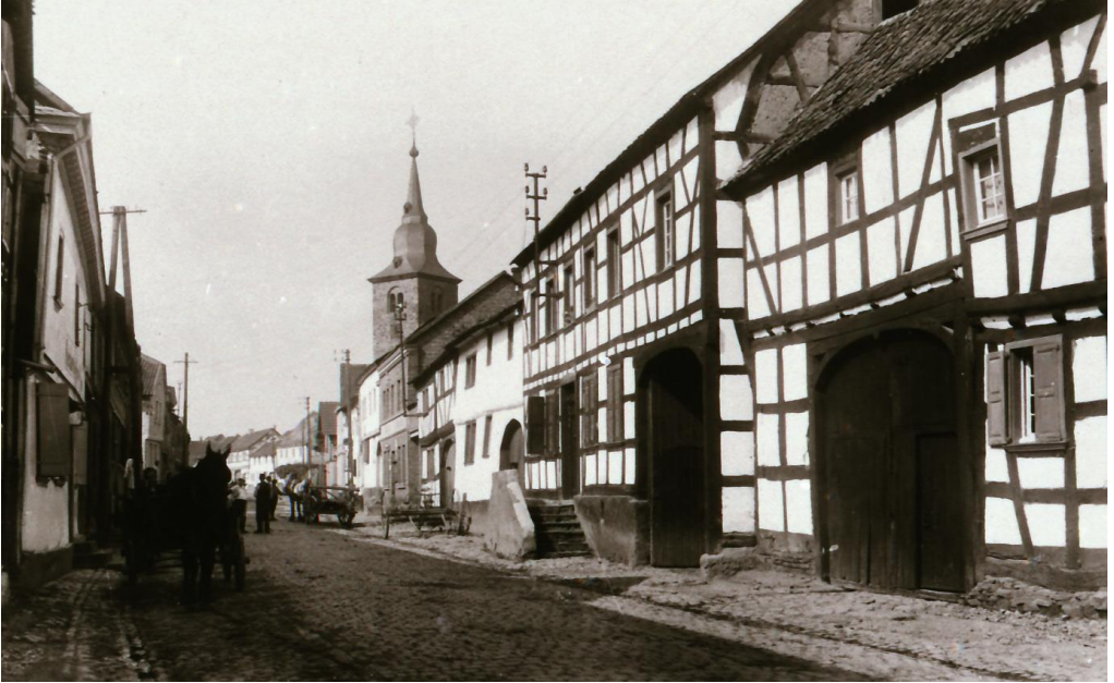
Die Fachwerkhäuser Bonner Straße 63 und 65 (ganz rechts), 1930er Jahre
