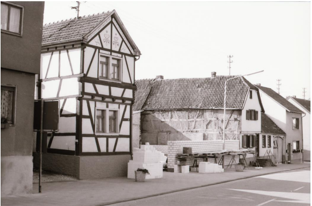
Oben die Häuser Bonner Straße 27 und 29 am 1. September 1976 und unten nach dem Abbruch von Haus Nr. 29 Schließung der Baulücke durch eine Mauer aus Kalksandsteinen. Die Genehmigung hierzu war am 29. Mai 1984 erteilt worden. 130 Aufnahme am 6. Juli 1984.
