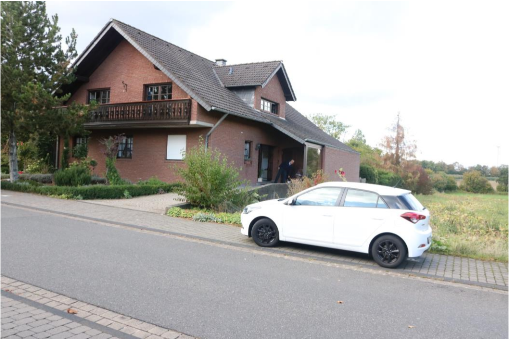
Eheleute Vogels beantragen 1987 die Genehmigung zur Errichtung eines Wohnhauses. 292 Aufnahme am 2. Oktober 2019.
