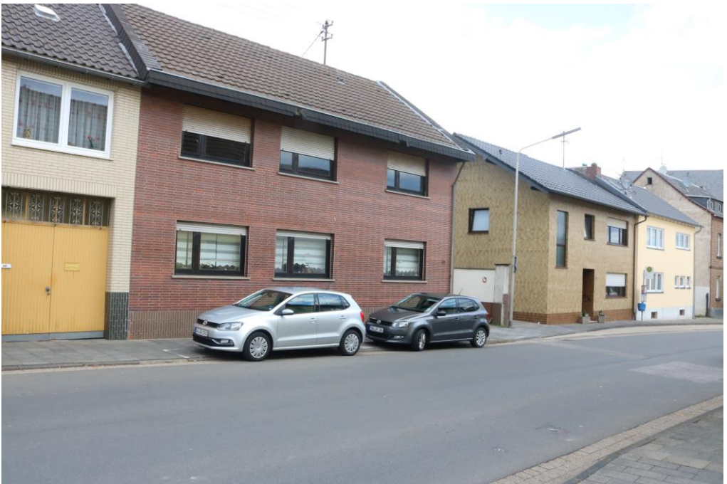
Bonner Straße 37 (links, rotbraune Keramikfliesen) am 18. Oktober 2019
