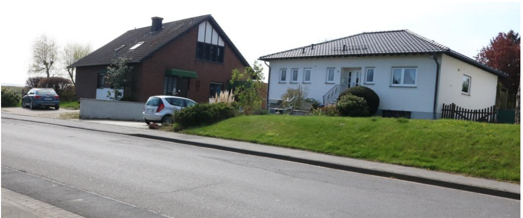
Baugenehmigung zum Haus Neuenahrer Straße 8 (links) am 15. Januar 1980. 304 Aufnahme am 16. April 2019.
