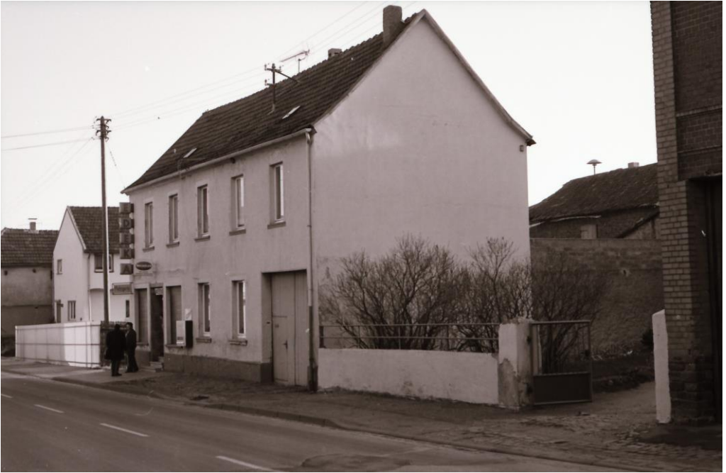
Foto vom 19. Januar 1975. Am hinteren Ende des Gebäudes erkennt man, dass sich dort ein Edeka-Laden befand.
