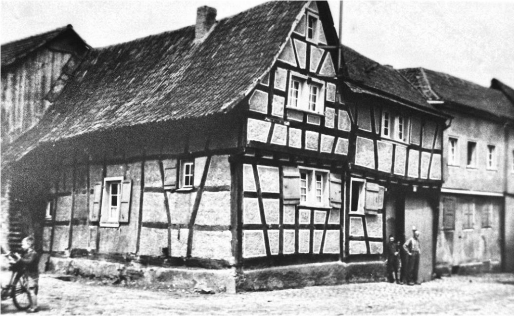
Das Foto entstand irgendwann vor dem Abbruch 1950. 224
