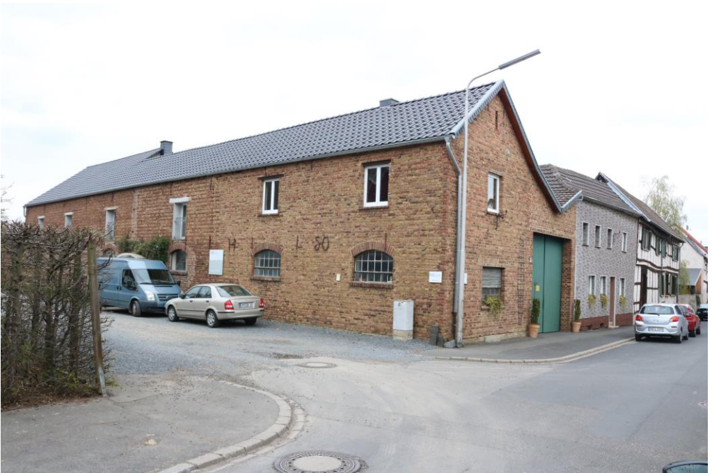
Heute (2019) steht hier dieser Ziegelsteinbau. An der Wand ist hinten am Weg mit Mauerankern 1933 K S und vorne die Jahreszahl 1950 angebracht worden. Dieses Gebäude dürfte der letzte Ziegelbau in Gelsdorf gewesen sein.
