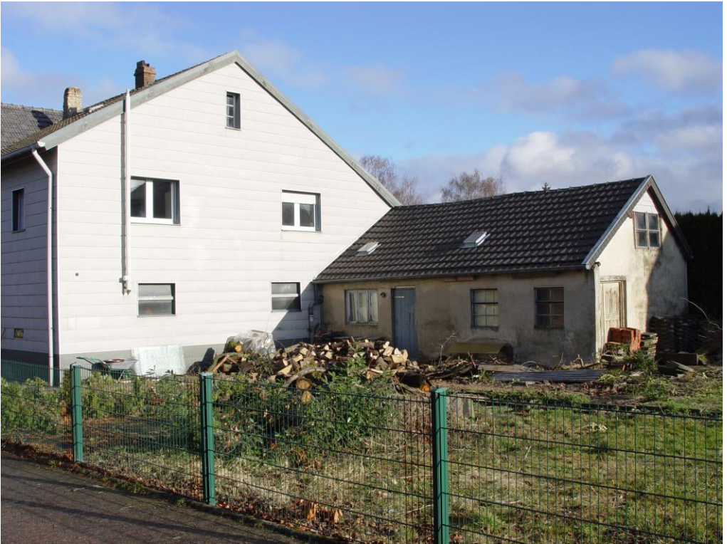
Haus „Hinter der Hage“ 36 am 15. Dezember 2012. Dieser parallel zur Straße „Auf dem Damm“ verlaufende Weg ist inzwischen fast vollständig bebaut. Der Name bezieht sich auf die Hage (in der Mundart Haach, gleich Hecke), die auf dem Damm als Dorfbefestigung wuchs.
