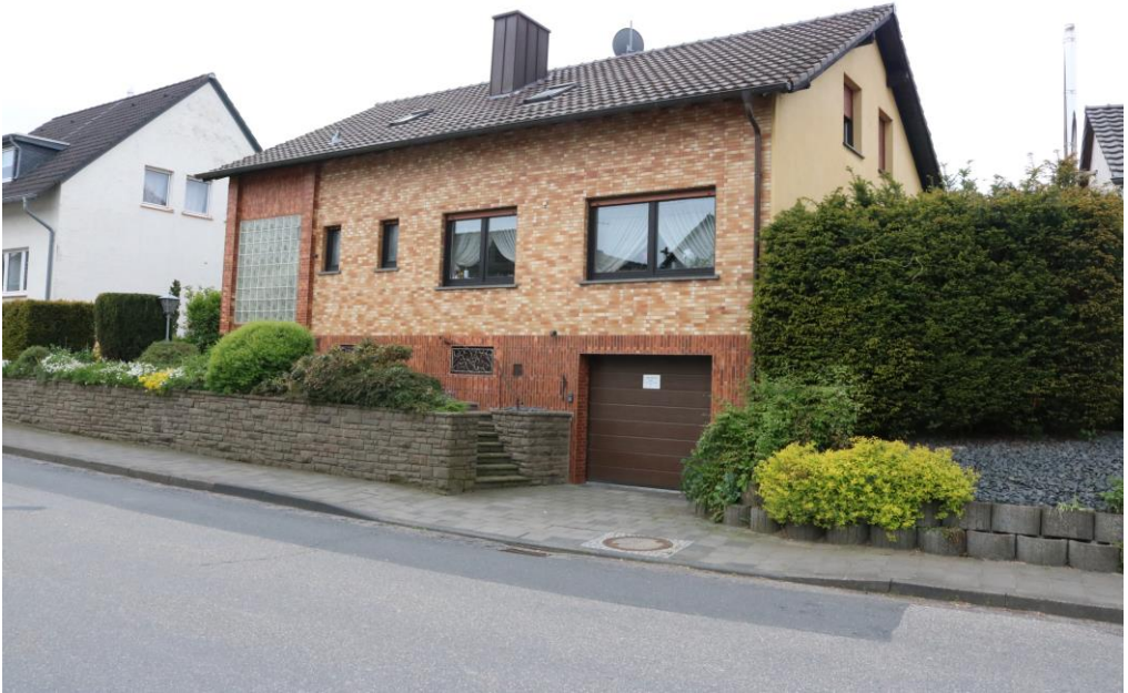
Foto vom 16. Mai 2019. Die Rohbauabnahme des Neubaus war am 15. August 1967. 265
