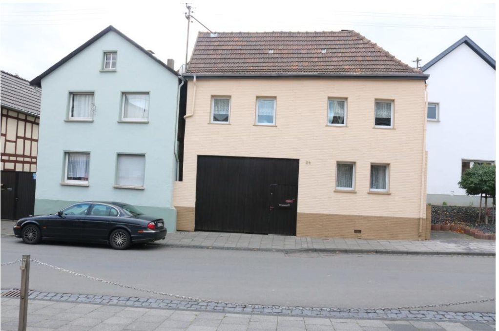
Haus Bonner Straße 54 (mit Tor) am 18. Oktober 2019. Eheleute Bäcker stellten 1986 einen Bauantrag zur Renovierung und Erweiterung ihres Wohnhauses mit Schmiede, verfolgten die Absicht aber vorerst nicht weiter. 159
