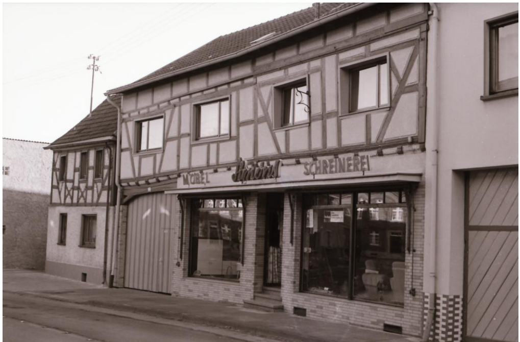
Bonner Straße 74 und 76 (von rechts) am 19. Januar 1975. Für die Erfordernisse des Möbelgeschäfts hatte man 1952/53 zwei Schaufenster eingebaut. 183
