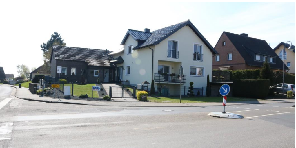
Links Haus Neuenahrer Straße 2, in der Mitte Altenahrer Straße 1a und rechts Altenahrer Straße 1, Foto vom 16. April 2019. Das Haus Altenahrer Straße 1 wurde 1977/78 errichtet. 104
