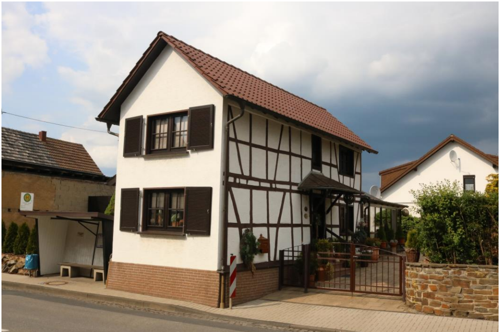
Foto am 18. Mai 2019. Ab 1972 erfolgten im hinteren Bereich des Grundstücks Baumaßnahmen nach Abbruch von Stall und Scheune. 251
