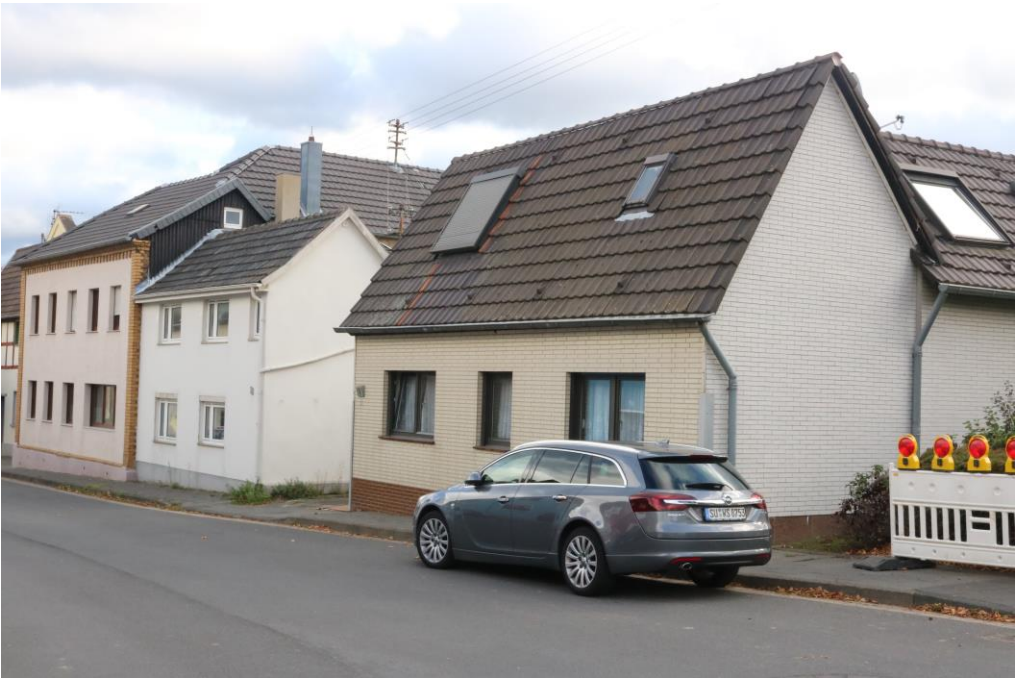
Die Häuser Bonner Straße 8, 10 und 12 (von rechts) am 18. Oktober 2019
