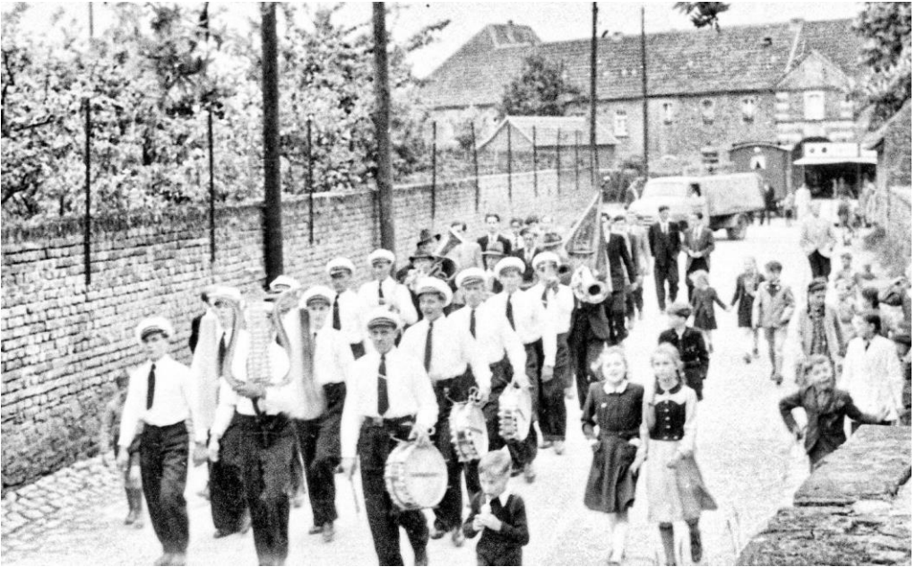
Ein Umzug in der Burgstraße, wohl in den 1960er Jahren. Links eine Mauer entlang des Hausgrundstücks Burgstraße 30, rechts die Kirchhofsmauer
