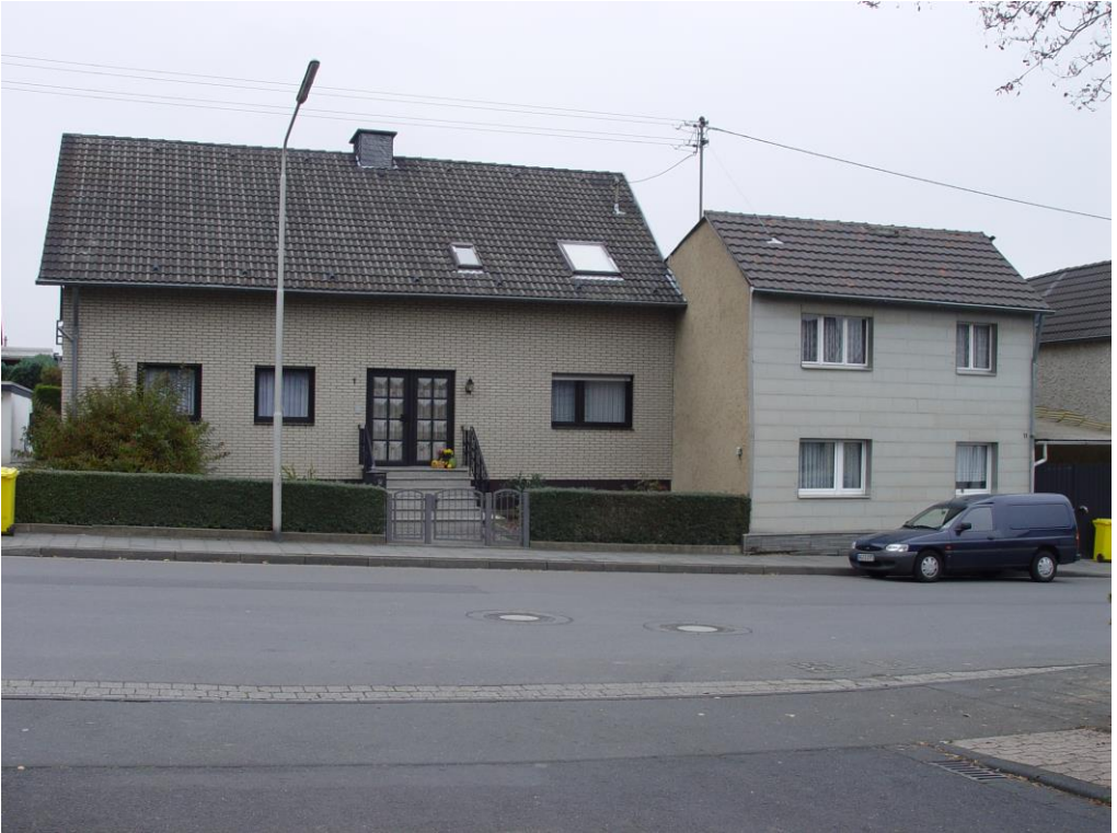
Neubau Bonner Straße 7 (Rohbauabnahme am 5. September 1980, 121 ) und Nr. 11 (rechts), Foto am 25. Oktober 2007
