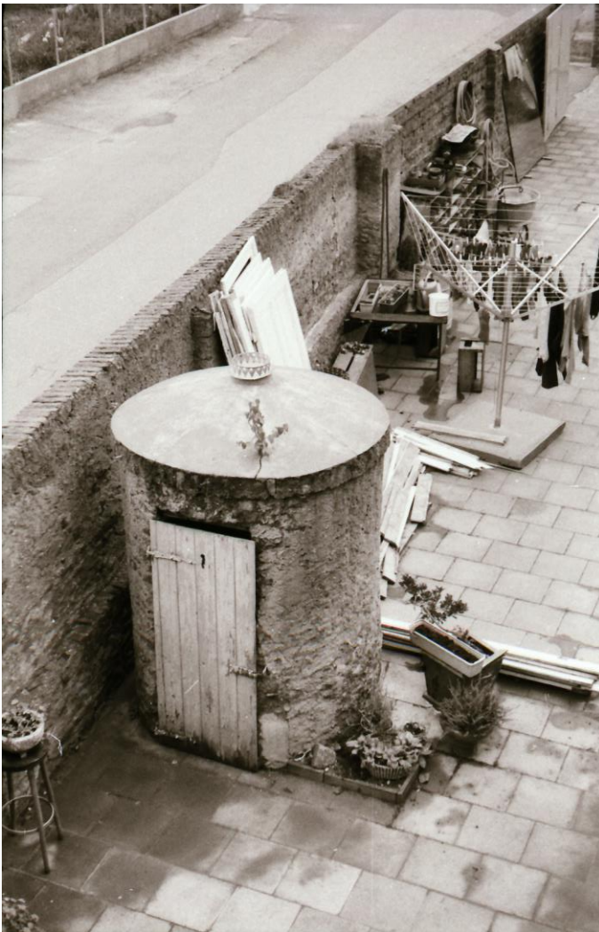
Eine Besonderheit am Haus Eckendorfer Straße 2 war die Form dieses „stillen Örtchens“ im Hof. Foto vom 12. September 1984.
