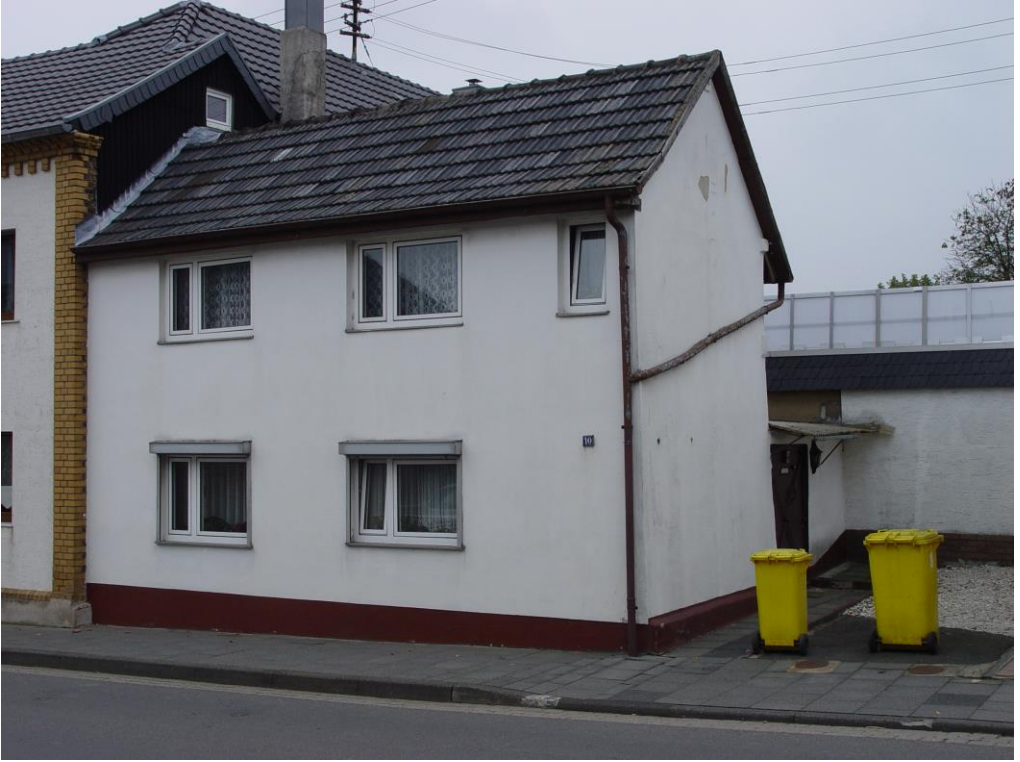
Haus Bonner Straße 10, Foto vom 25. Oktober 2007
