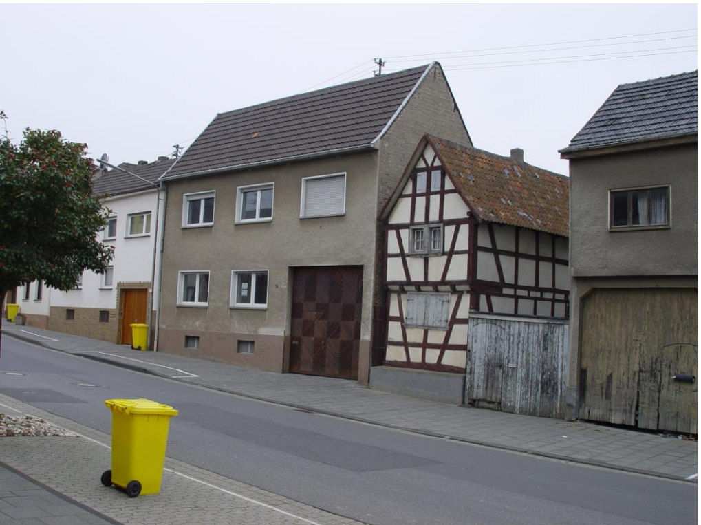
Bonner Straße 21, 23 und 25, Aufnahme am 25. Oktober 2007
