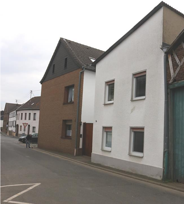
Häuser Burgstraße 1 (links) und 1b. Das Haus 1 a liegt im Innenhof. Zustand am 12. April 2019.
