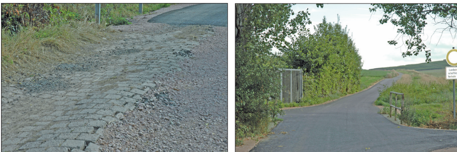
Abbildung 14: Asphaltweg, Region Mainz/Bingen
