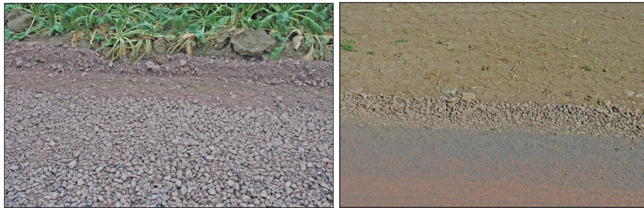
Abbildung 5: Befestigung ohne Bindemittel mit und ohne Deckschicht
