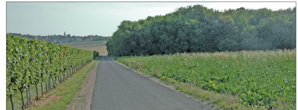
Abbildung 12: Asphaltweg- Region Mainz/Bingen
