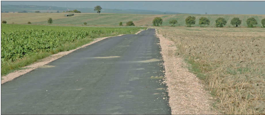
Abbildung 13: Asphaltweg, Region Mainz/Bingen
