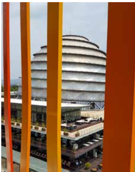
Die Kuppel des Convention Centers in Kigali ist ein Sinnbild für das moderne Ruanda von heute.
