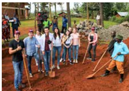
Beim Besuch der Partnerregion konnte der gemeinsame Spatenstich für das Bauprojekt „Wasserversorgung“ gesetzt werden (Foto: Freundeskreis Boppard).
