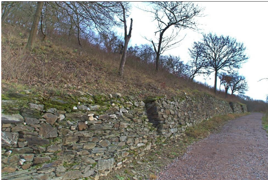
Trockenmauern am Weg oberhalb des Wasserhauses
