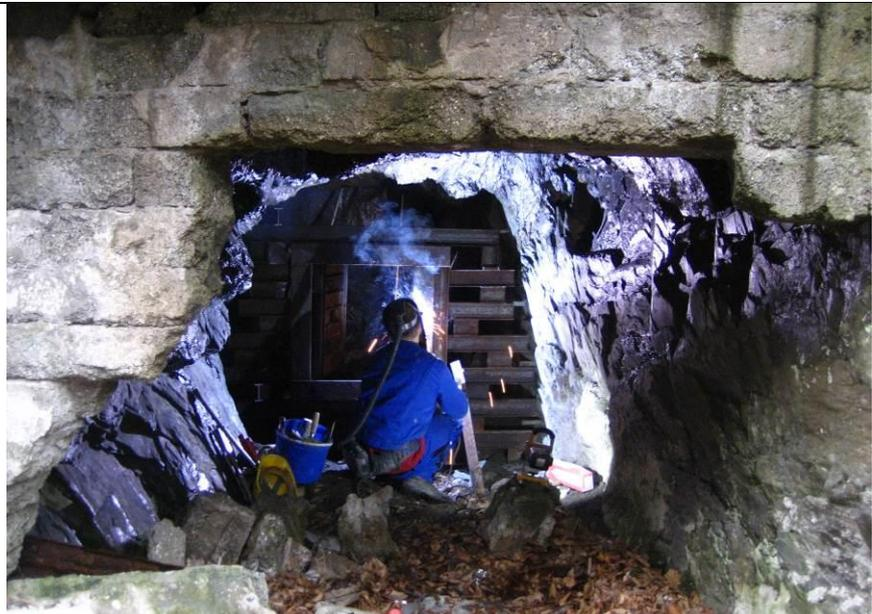
Fertig erstelltes Gittertor auf Betonsockel, damit es nicht untergraben werden kann. Nur die aufwändigste und massivste Sicherung der unterirdischen Überwinterungsquartiere bieten die größtmögliche Einbruchssicherheit. Einfachere Stollensicherungen sind funktionsuntüchtig und sollten nicht mehr zum Einsatz kommen.
