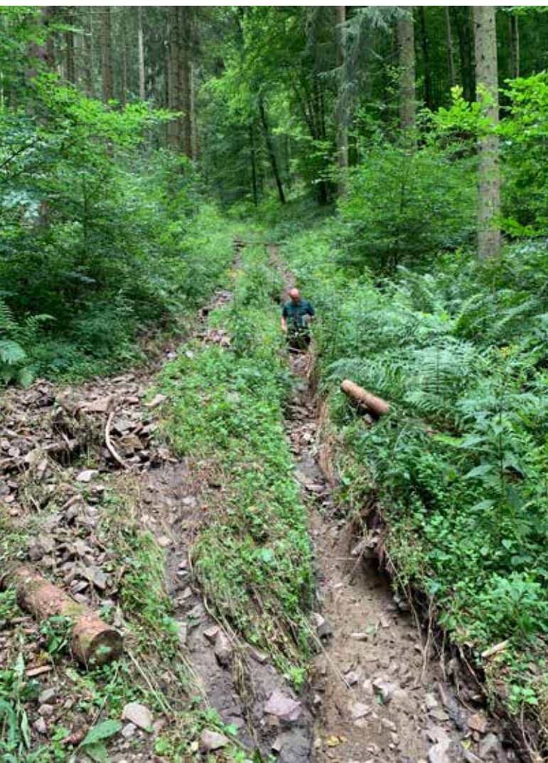
Rinnen-Erosion in der Sohle eines auch als Rückeweg genutzten V-Tales in der Nähe des Aufnahmepunktes 148 der Waldzustandserhebung. Der Punkt liegt in mittlerer Höhe in einem Seitental der Ahr bei Schuld. Bei Starkniederschlägen sammelt sich das Wasser auch in mehrstufigen Mischwäldern mit Bodenvegetation im normalerweise trockenen Talgrund und führt zum Fortschreiten der Vertiefung, auf diese Weise entstand und entwickelt sich ein V-Tal. Foto: Sonja Blum
