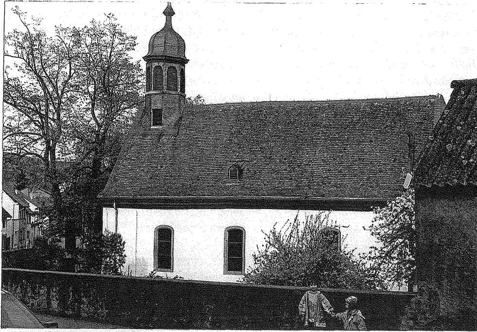
Blick von der Kriegsfelder Straße auf die Kirche
