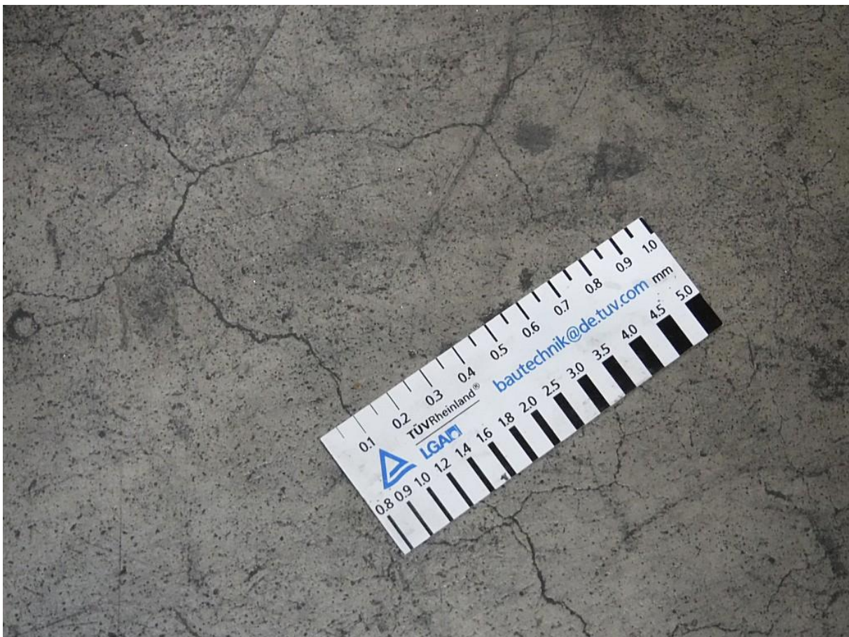
Abbildung 3 – Rissbreitenmessung mit Risslineal
