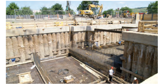
8 Bewehrungsarbeiten für die Sohle des Pumpwerkes
