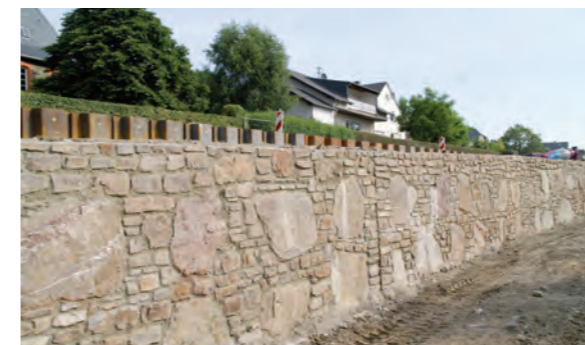
3 Wasserseitige Natursteinmauer im Bereich der Hochwasserschutzwand
