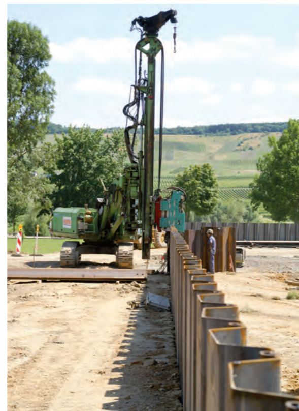
11 Spundwandarbeiten im Bereich der Durchfahrt 4
