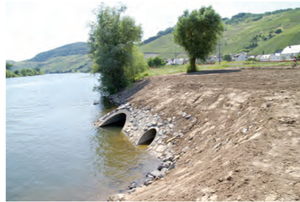
6 Auslaufbauwerke Außenbereichsentwässerung und Entlastungsleitung Pumpwerk
