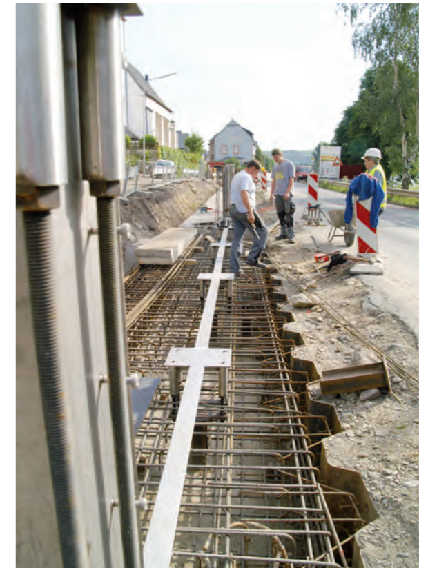
4 Hochwasserschutzwand, Einbau Bodenschiene und Ankerplatten für das mobile System
