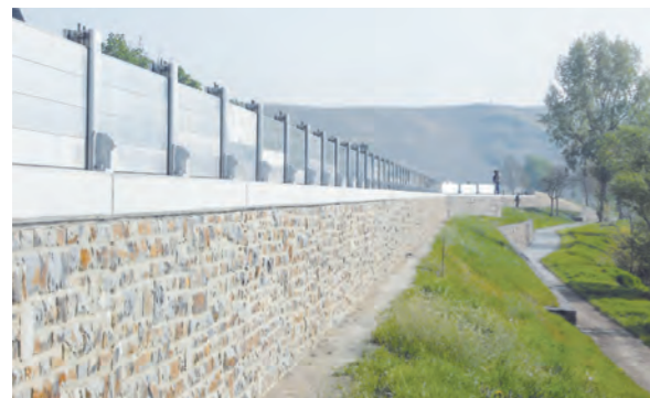
9 Hochwasserschutzwand, Probeaufbau mobiles Hochwasserschutz-System
