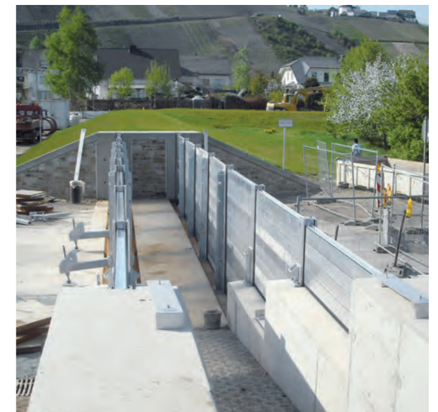
5 Probeaufbau mobiles Hochwasserschutz-System in einer Durchfahrt
