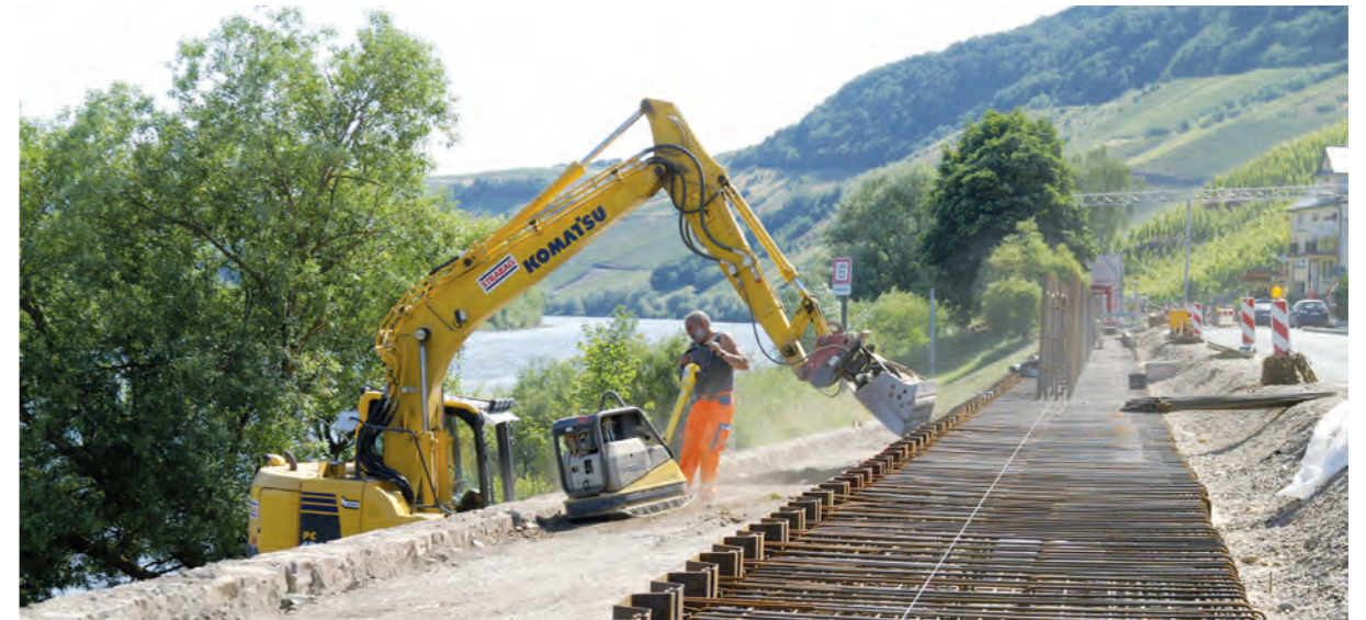
12 Hochwasserschutzwand, Bewehrungsarbeiten Kopfbalken
