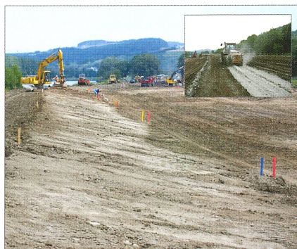
20 Anlage des Retentionsraumes 21 kleines Foto: Bodenverbesserungsmaßnahmen im Retentionsraum
