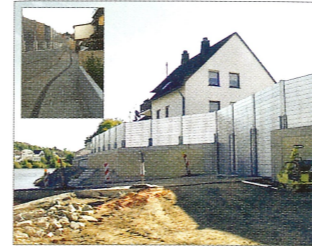
12, 13 Hochwasserschutzwand in Abschnitt c
