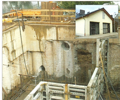
18 Baugrube Pumpwerk 19 kleines Foto: Pumpwerk und Lager für mobile Hochwasser-Elemente
