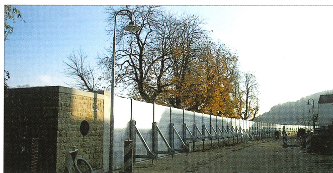
7 Dorfplatz nach dem Bau der Hochwasserschutzwand
