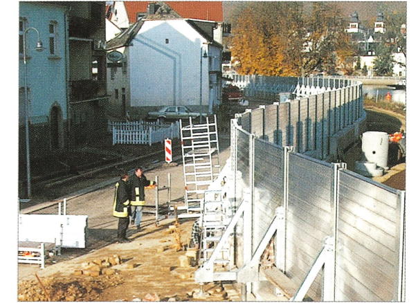
16 Mobile Hochwasserschutzwand entlang des Dorfplatzes
