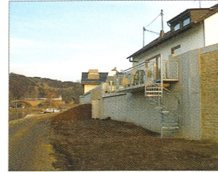
10 Hochwasserschutzwand entlang der Bebauung in Abschnitt B
