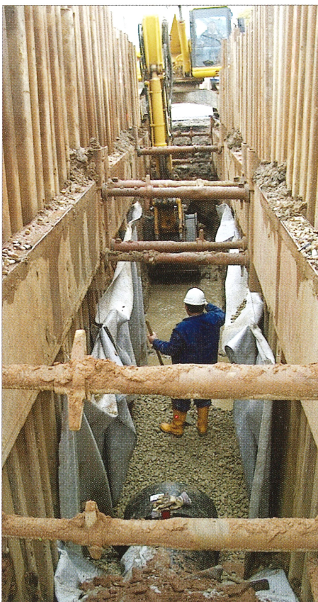
17 Verlegung der Tiefendrainage
