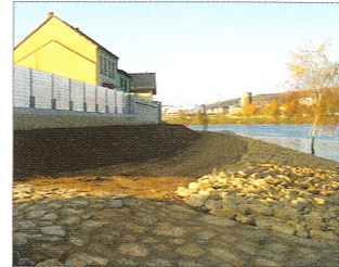
11 Hochwasserschutzwand in Abschnitt B
