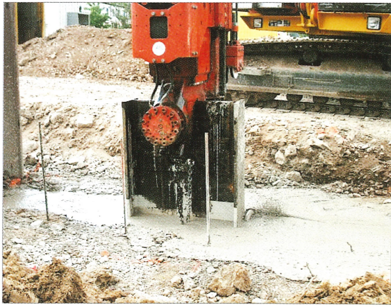
8 Einbringen der Rüttelschmalwand
