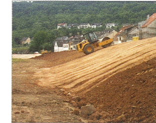
15 Einbau des wasserseitigen Auflastfilters in Abschnitt E
