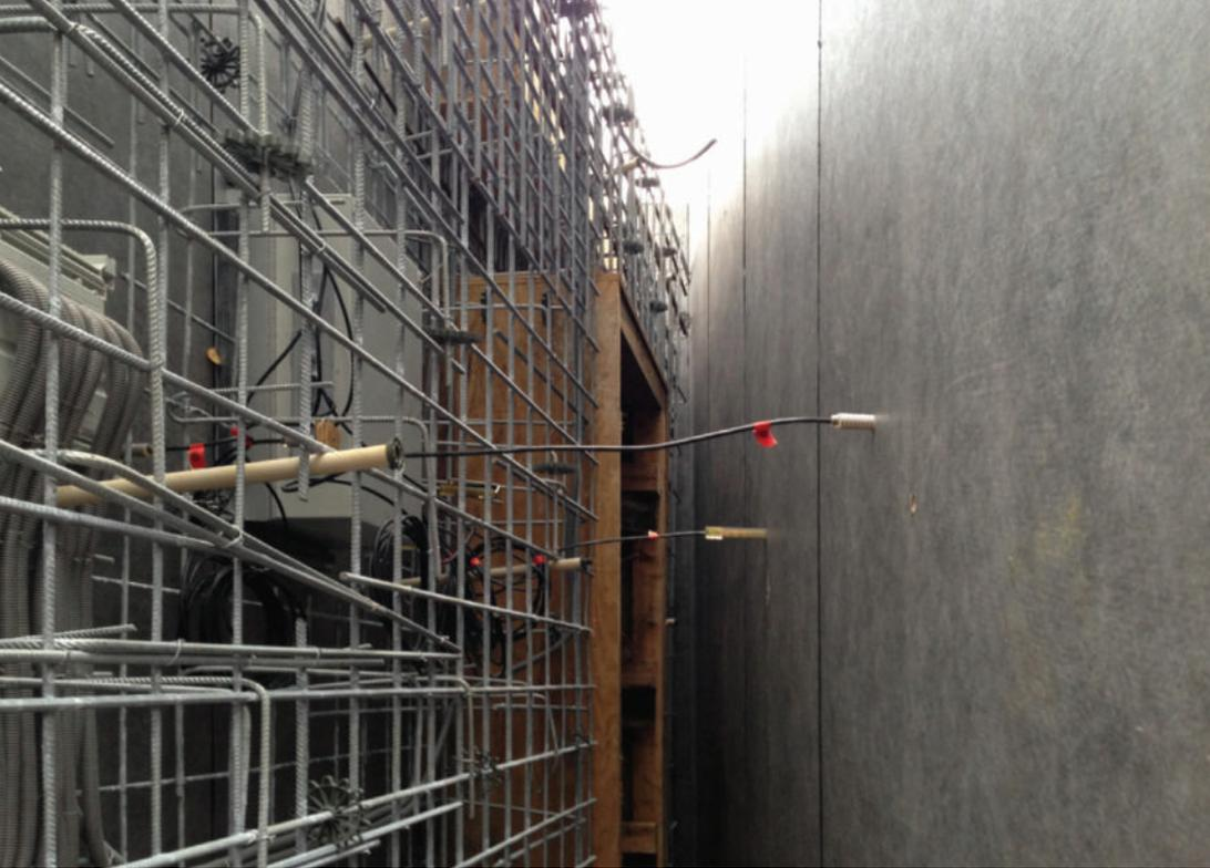
Abb.13: An der Außenschalung befestigte Multiringensorelektroden (MRSE) für das Bauwerksmonitoring
