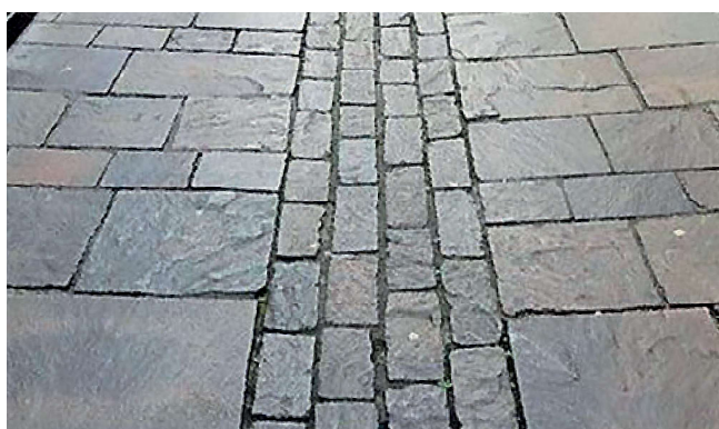
Abb. 8.30 – Mehrzeilige Natursteinpflasterrinne aus Porphyr
