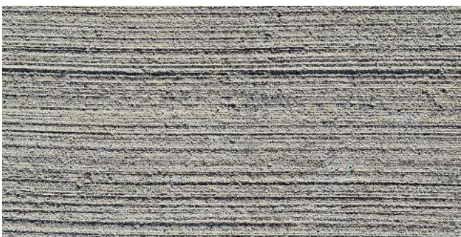
Abb. 8.22 – Oberflächentextur einer Betonfläche mittels Stahlbesenstrich
