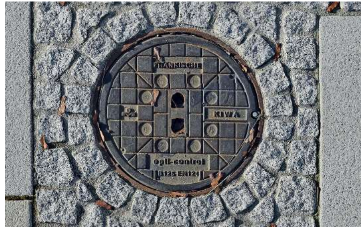
Abb. 8.21 – Verfestigte Fugen mit Mosaikpflaster aus Granit an einem Schieber
