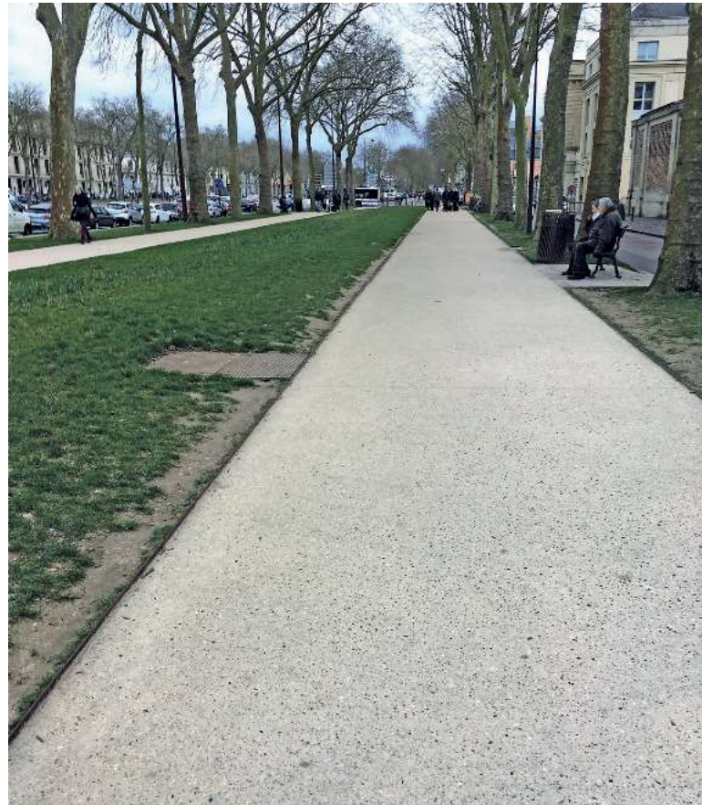
Abb. 8.23 – Helle Gehwegfläche in Betonbauweise mit einer Randeinfassung aus Cortenstahl vor dem Schloss Versailles bei Paris
