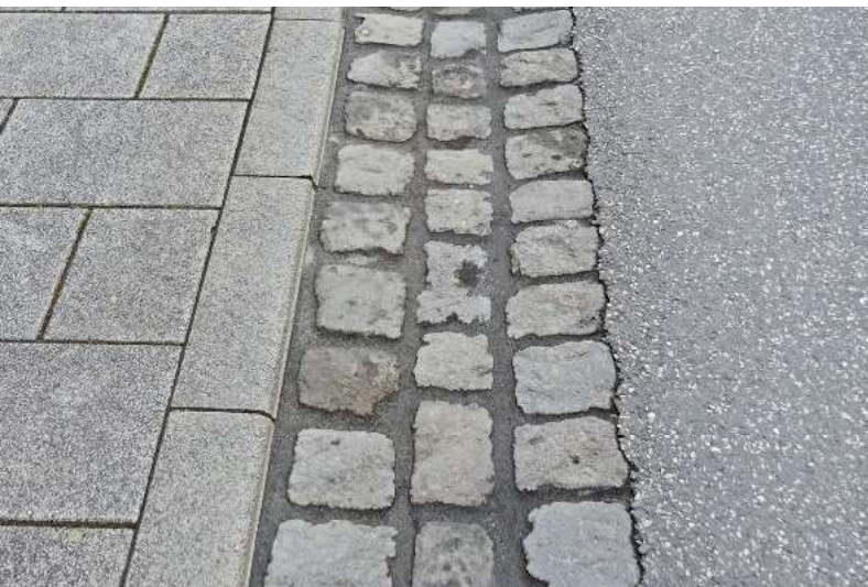
Abb. 8.26 – 3-zeilige Rinne und Bordstein aus Basalt
