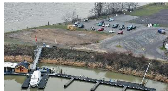
Abb. 6.37 – Flächennutzung und Gestaltung in St. Goar vor Umbau
