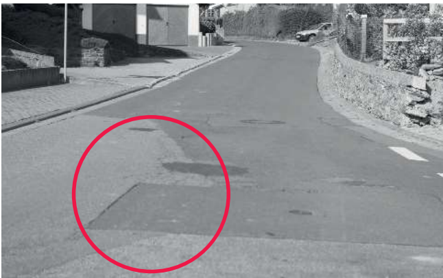
Abb. 8.9 – Andersfarbig hergestellte Deckschichten nach Aufgrabung in einer Ortslage
