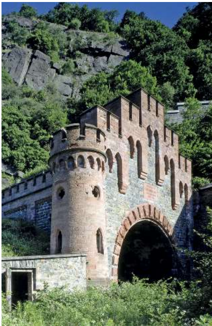
Abb. 1.16 – Unter Denkmalschutz stehendes Tunnelportal der DB-AG
