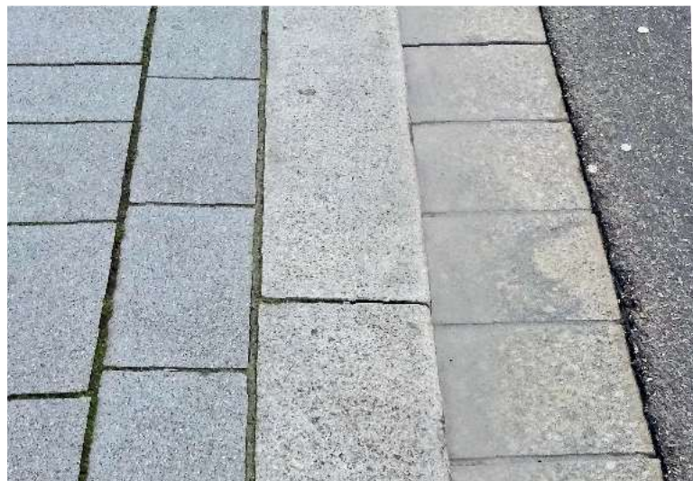
Abb. 8.27 – Rinnenplatte und Bordstein aus Granit
