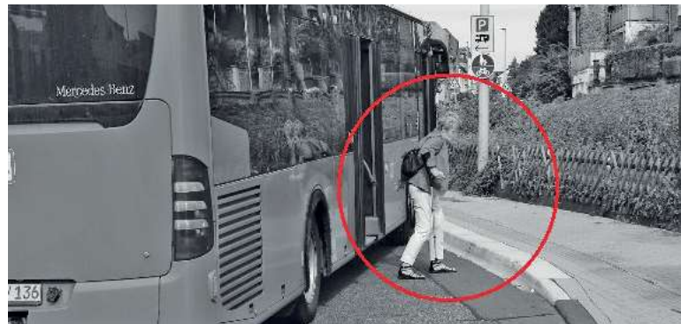
Abb. 4.9 – Die Busbucht kann nicht optimal angefahren werden, der Spalt zwischen der hinteren Tür und dem Busbord ist viel zu groß
