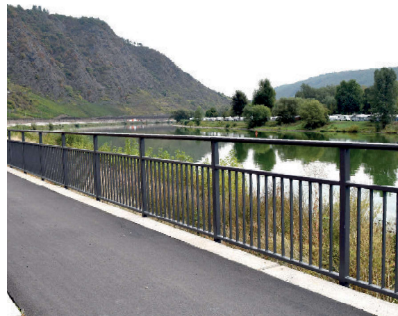
Abb. 5.16 – Dunklere Schutzeinrichtungen passen sich zurückhaltender in das Landschaftsbild ein, hier an der B 49 vor Cochem
