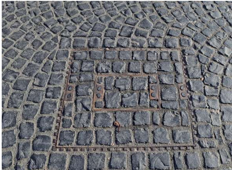
Abb. 8.11 – Basaltkleinpflaster im Schuppenverband und gebundener Bauweise mit integriertem, ausgepflastertem Schachtdeckel
