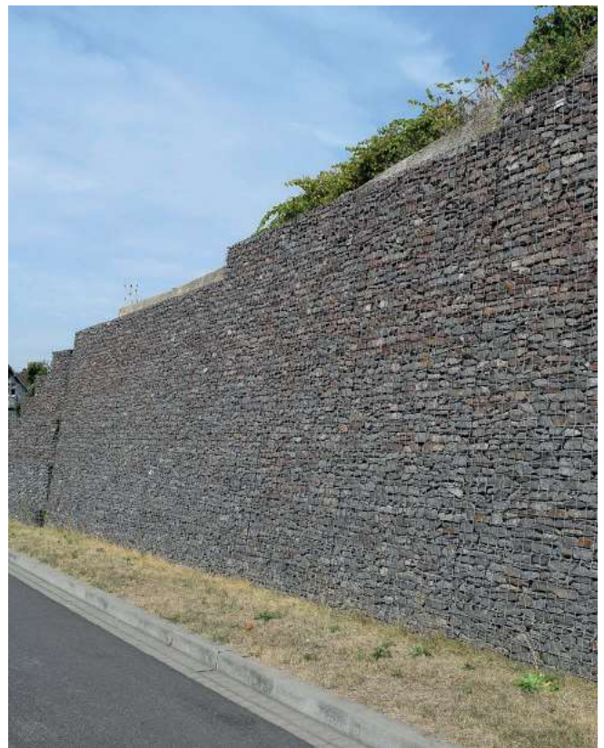
Abb. 10.10 – Natursteingabionen zur Hangsicherung an der B 42 bei Hammerstein
