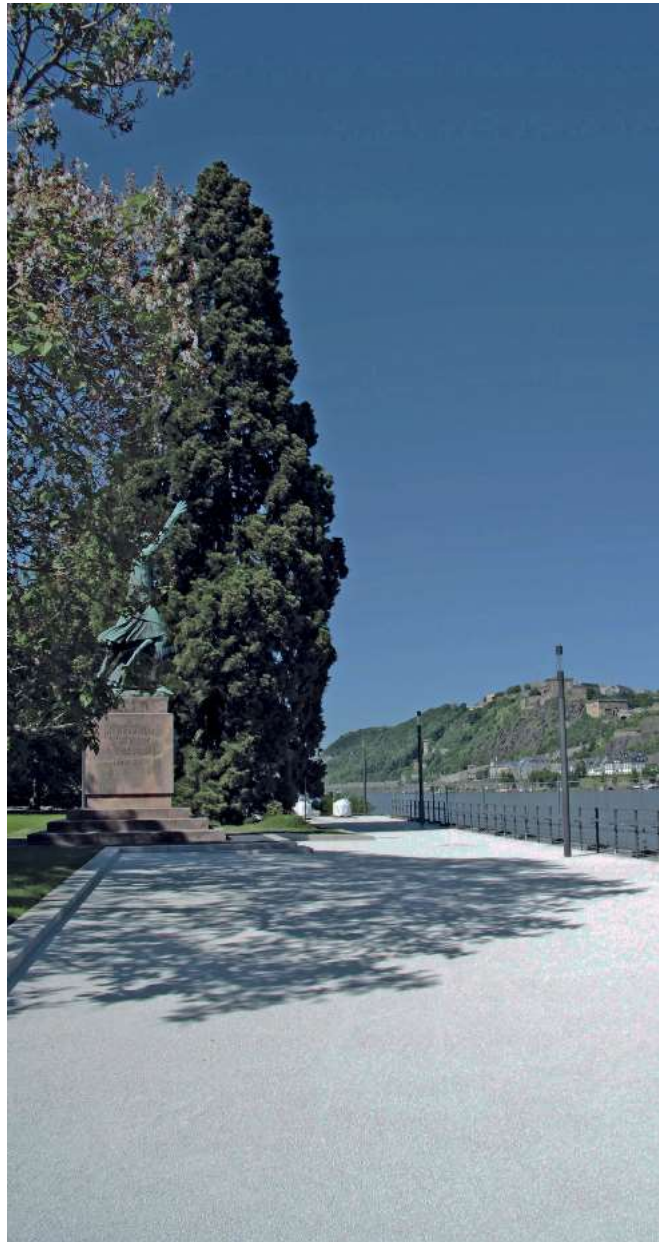
Abb. 8.8 – Oberflächentextur einer mit Reaktionsharz und heller graubeiger Abstreuung behandelten Asphaltoberfläche in Koblenz
