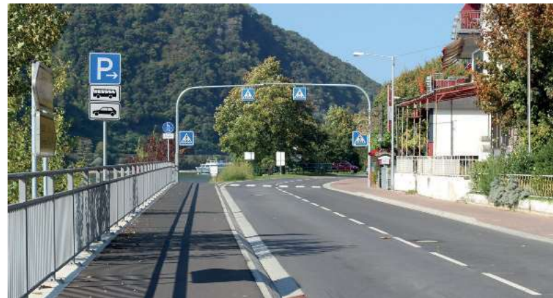
Abb. 6.33 – Ein engerer Straßenraum erfordert Borde und Füllstabgeländer als passive Schutzmaßnahmen, Kamp-Bornhofen
