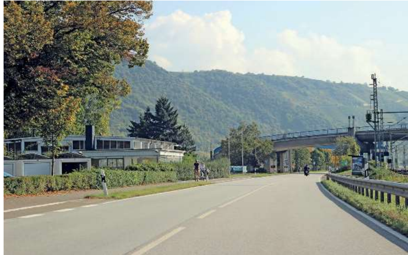
Abb. 8.3 – Helle Walzasphaltdeckschicht an der B 42 bei St. Goar
