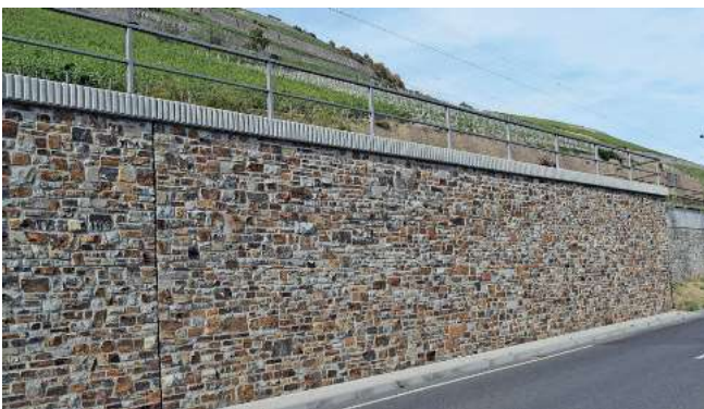
Abb. 10.9 – Mit Natursteinen verkleidete Stützkonstruktion an der B 42 zwischen Lorch und Rüdesheim
