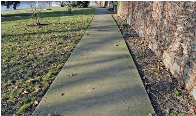
Abb. 8.24 – Patina eines Gehweges in Betonbauweise nach rund 6 Jahren Nutzungsdauer
