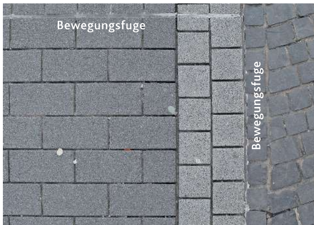
Abb. 8.16 – Gebundene Pflasterbauweise mit Beton- und Natursteinpflaster sowie Bewegungsfugen
