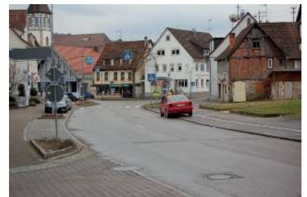
Abb. 6.4 und 6.5 – Entstehung von Stadtraum durch Anpassung der Ortsdurchfahrt an die Bedürfnisse von Fußgänger und Radfahrer
