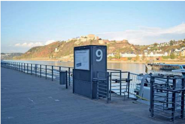
Abb. 9.7 – Beispielhafte Lösung einheitlicher Gestaltung von Geländer und der technischen Versorgungsanlagen der Schiffssteiger; Rheinpromenade Koblenz
