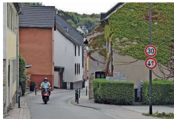
Abb. 6.17 – Typische Engstelle in einer Ortsdurchfahrt, weiche Ausbildung, schmale Seitenräume werden mit Pollern geschützt
