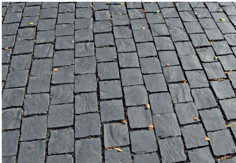
Abb. 8.12 – Eben gespaltene Oberfläche eines Großpflasters aus Basalt in ungebundener Ausführung
