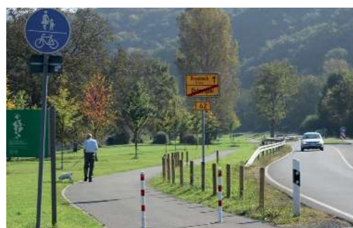
Abb. 5.14 – Selbstständig geführter Radwegeabschnitt entlang der B 42 am Ortsende von Osterspai
