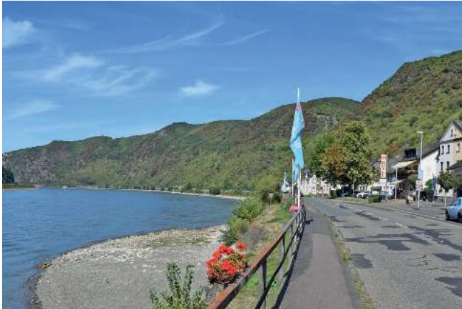
Abb. 2.4 – Ist-Situation 2018 – Bundesstraße B 42 und das sehr schmale Rheinvorgelände in Kestert, Blick Richtung Norden
