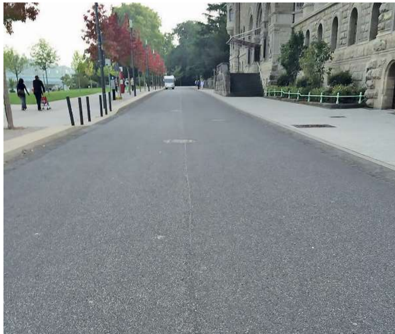
Abb. 8.4 – Dunkle Walzasphaltdeckschicht am Konrad-Adenauer-Ufer in Koblenz
