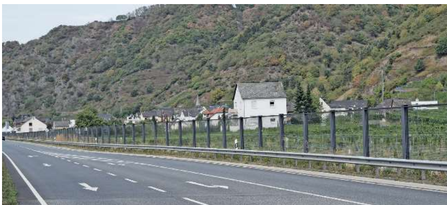
Abb. 10.7 – Schallharte, transparente Lärmschutzwand an der B 42 bei Hammerstein
