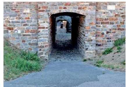
Abb. 1.12 – Trennwirkung – Bahnstrecken erfordern eine Vielzahl von Fußgängerunterführungen
