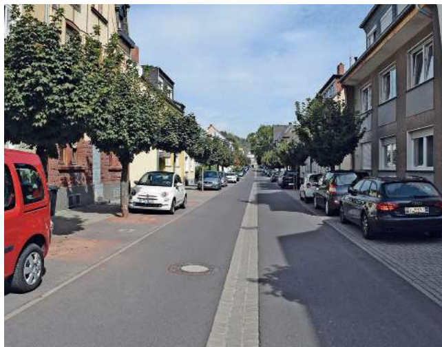
Abb. 8.29 – 3-zeilige Muldenrinne in Asphaltfahrbahn
