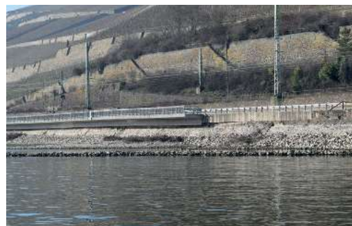
Abb. 5.13 – Führung des Radweges auf einem Kragarm entlang der B 42 bei Rüdesheim
