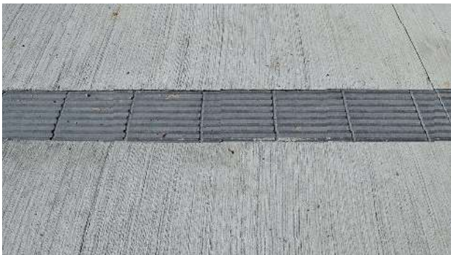
Abb. 8.25 – Gehweg auf dem Loreley-Plateau in Betonbauweise mit kontrastreichen, taktilen Leitstreifen
