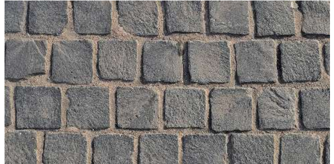
Abb. 8.13 – Ebenes Basaltkleinpflaster in gebundener Bauweise
