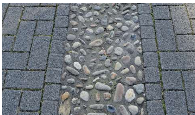
Abb. 8.28 – Sonderkonstruktion einer Betonrinne mit Flusskies
