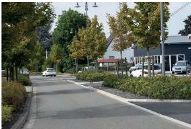
Abb. 10.1 – Seitliche Aufpflasterung wie in Brey sichert die Befahrbarkeit der B 9 für militärische Fahrzeuge
