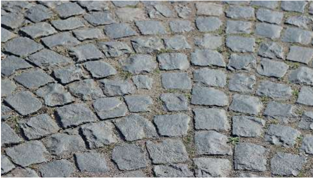
Abb. 8.18 – Unebenes Basaltkleinpflaster in ungebundener Bauweise
