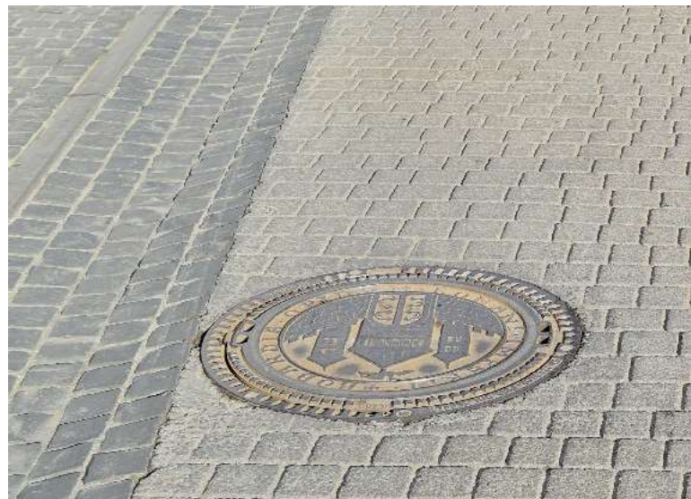
Abb. 8.6 – Kombination aus Basaltkleinpflaster in den Nebenflächen und Prägeasphalt in Pflasteroptik in der Fahrbahn in Boppard
