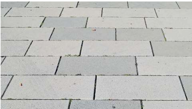
Abb. 8.19 – Reihenverband mit verschiedenen Pflasterformaten und Farben
