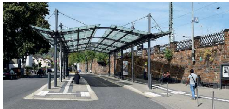
Abb. 4.10 – Gut umgesetztes Gestaltungskonzept mit taktilem Leitsystem am Busbahnhof in Andernach
