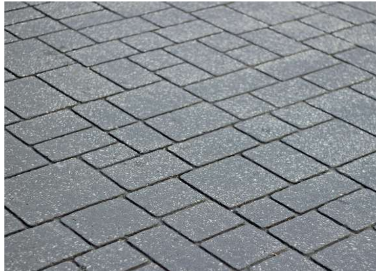
Abb. 8.5 – Gussasphalt mit Pflasterprägung, kaum zu unterscheiden von einer konventionellen Pflasterfläche, jedoch erheblich verformungsstabiler
