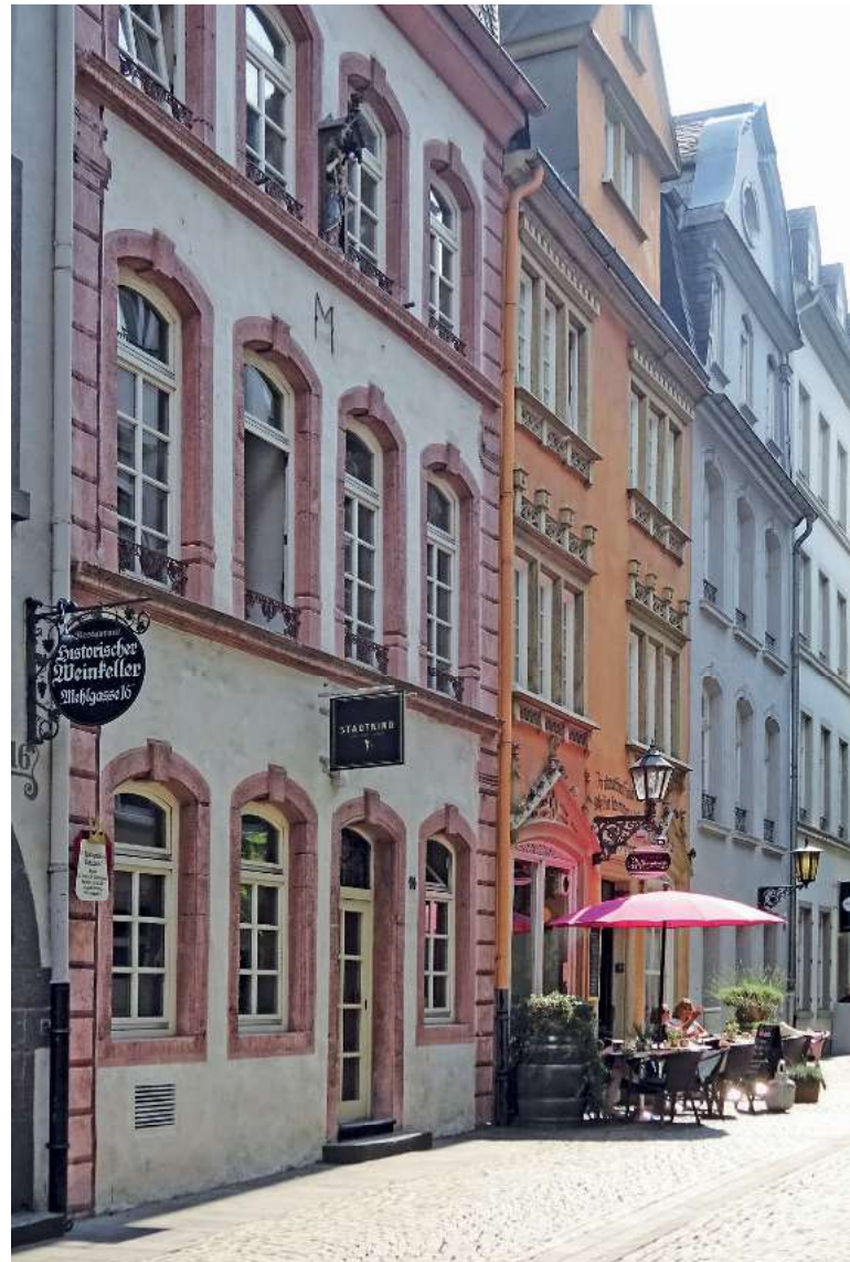
Abb. 6.19 – Historische Ortslage, Mischprinzip von Straßen- und Seitenraum, Belag aus Natursteinpflaster mit Mittelrinne
