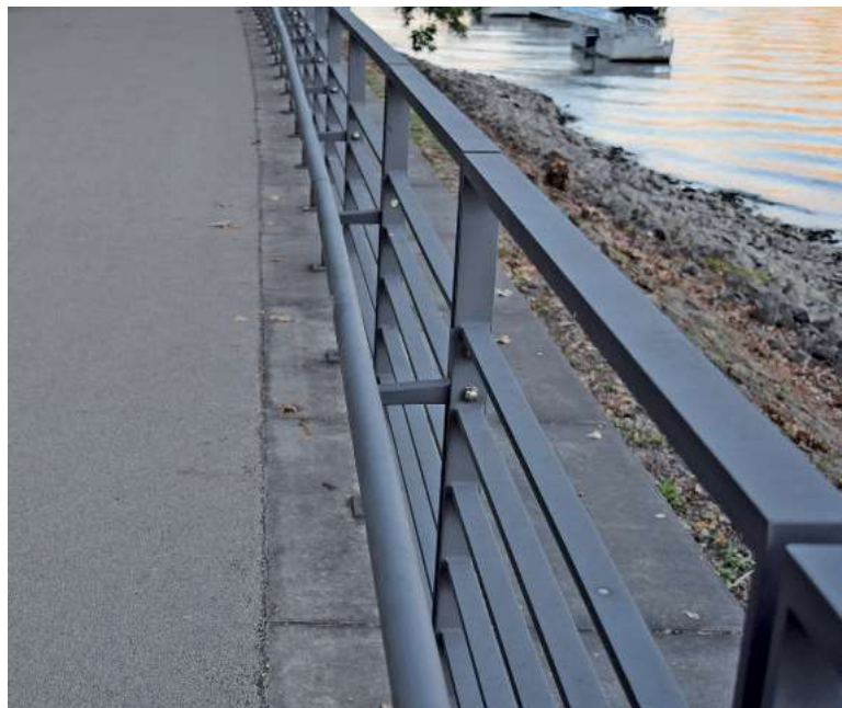
Abb. 9.10 – Geländer mit horizontaler Teilung und Übersteigschutz
