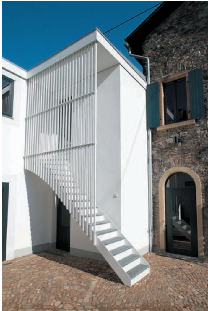
Diese Überlegung führt tatsächlich auch schon zur Energiereduzierung, denn nicht alle Funktionsbereiche müssen beheizt werden. Das gilt nicht nur für ins Freie ausgelagerte Räume, sondern auch für Innenräume, so untersucht das Fraunhofer-inHaus-Zentrum gedämmte Innenwände, die weniger beheizte bzw. nicht beheizte Räume von beheizten trennen.
