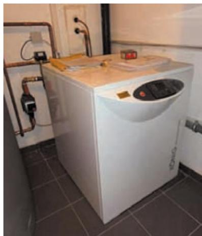
Voraussetzung für den Einsatz von Wärmepumpen sind geringe Vorlauftemperaturen des Heizungssystems. Dies ist vor allem durch Einsatz einer Flächenheizung gegeben. Neben der üblichen Verlegung im Fußboden gibt es auch noch die Möglichkeit die Heizungsrohre
