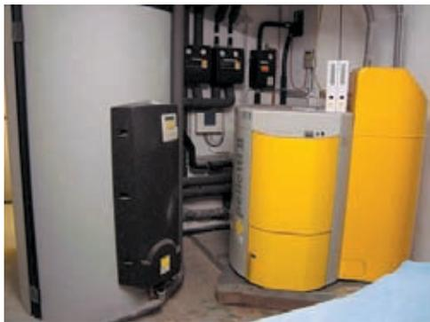
Hier zu sehen ein automatisch beschickter Kessel mit zusätzlichem Pufferspeicher. Die Lagerung der Holzpellets erfolgt z.B. in einem Vorratsraum oder Silo.
