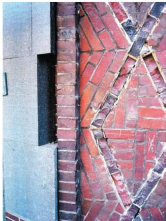
Statt Maßnahmen anzuwenden, die sich an den Vorgaben des Baukomplexes orientieren, werden, wie etwa im ehemals wertvollen Bauensemble im Dortmunder Kronprinzenviertel, die vorstehenden Backsteine abgeschlagen und die Fassade hinter einer Dämmschicht verpackt (Abb.).
