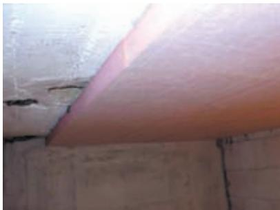
Mit Hilfe der Dämmung können innere Oberflächentemperaturen erhöht und thermisch bedingte Zugerscheinungen vermieden sowie ein besseres Raumklima geschaffen und Bauschäden vorgebeugt werden.
