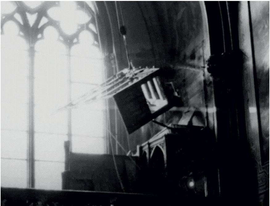
1966 Blick auf die Orgelempore während des Abbaus
