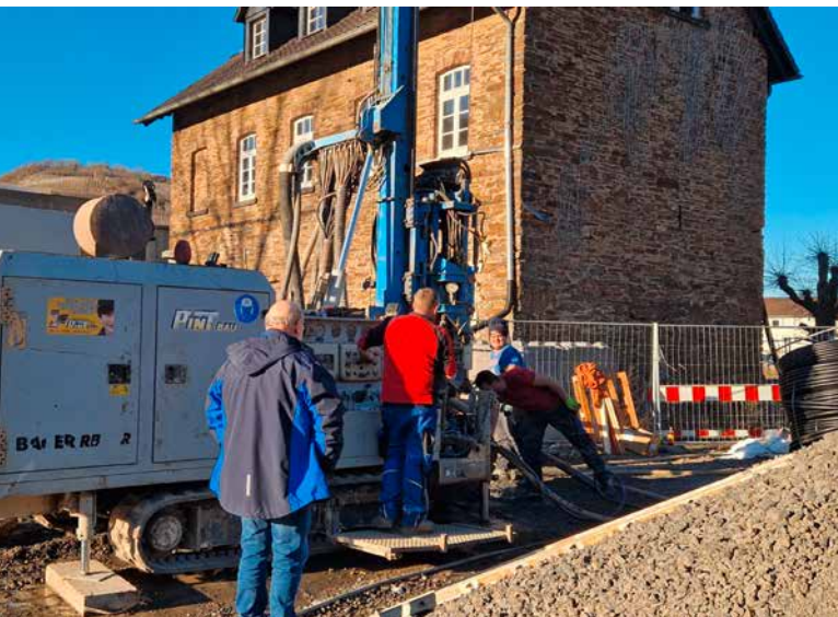
Probebohrung für kalte Dorfwärme in Rech
