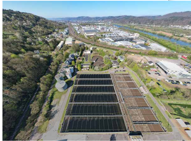
Klärwerk mit Nachklärbecken
