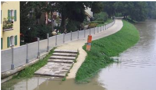
Abbildung 76: Widerstehen und Abschirmen – Mobile Wasserschutzwand (links), Abdichten des Gebäudes (rechts); Quellen: https://www.br.de/nachricht/inhalt/hochwasserschutz-bayern-114.html Wassersensibel planen und bauen in Köln, Leitfaden zur Starkregenvorsorge für Hauseigentümer, Bauwillige und Architekten, StEB Köln, S.16
