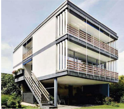
Abbildung 75: Ausweichen; Aufständigung (links); „Nasse Vorsorge“ (rechts); Quellen: Hochwasser-Risiko-bewusst planen und bauen, WBW Fortbildungsgesellschaft für Gewässerentwicklung, Februar 2015, S.29. & Wassersensibel planen und bauen in Köln, Leitfaden zur Starkregenvorsorge für Hauseigentümer, Bauwillige und Architekten, StEB Köln, S.16
