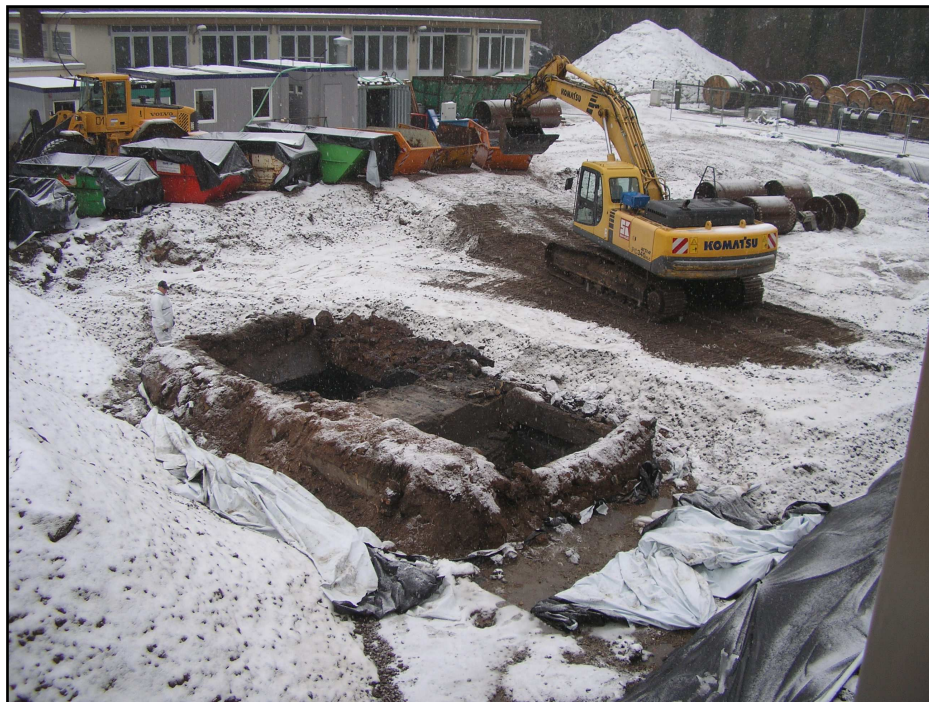
Abbildung 12: Erschließungs- und Freilegungsarbeiten im Bereich des Schadensherdes SH1 (Kondensatgruben)
