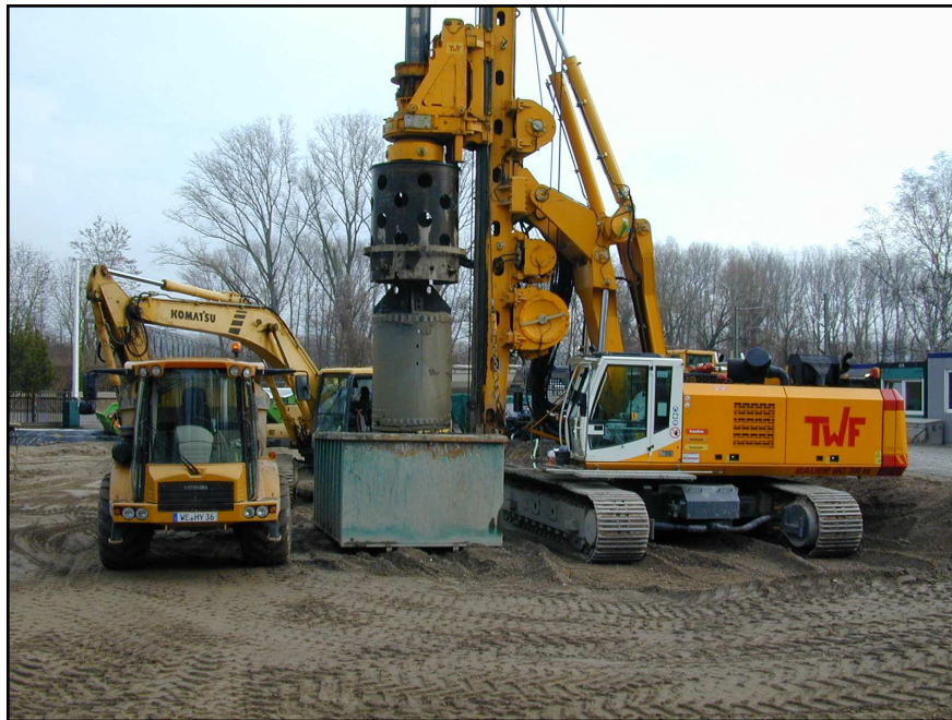
Abbildung 15: Großlochbohrgerät im Sanierungseinsatz (Vorgang \Rightarrow Entleeren des Bohreimers in Auffang- und Absetzmulde)
