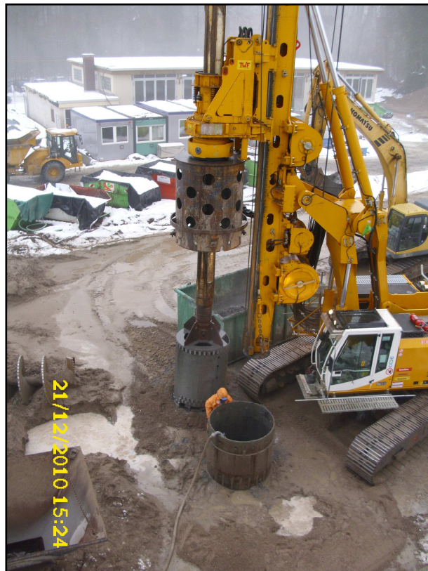
Abbildung 14: Großlochbohrgerät im Sanierungseinsatz (Vorgang => Einbringen von sauberem Austauschwasser als Wasserauflast innerhalb des Mantelrohrs)
