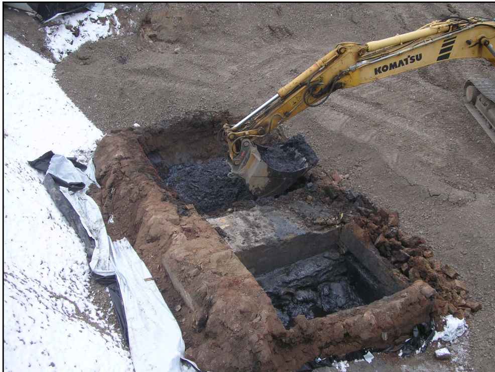
Abbildung 13: Auskofferungs- und Rückbauarbeiten im Bereich des Schadensherdes SH1 (Kondensatgruben = Teer- und Ammoniakwassergrube)
