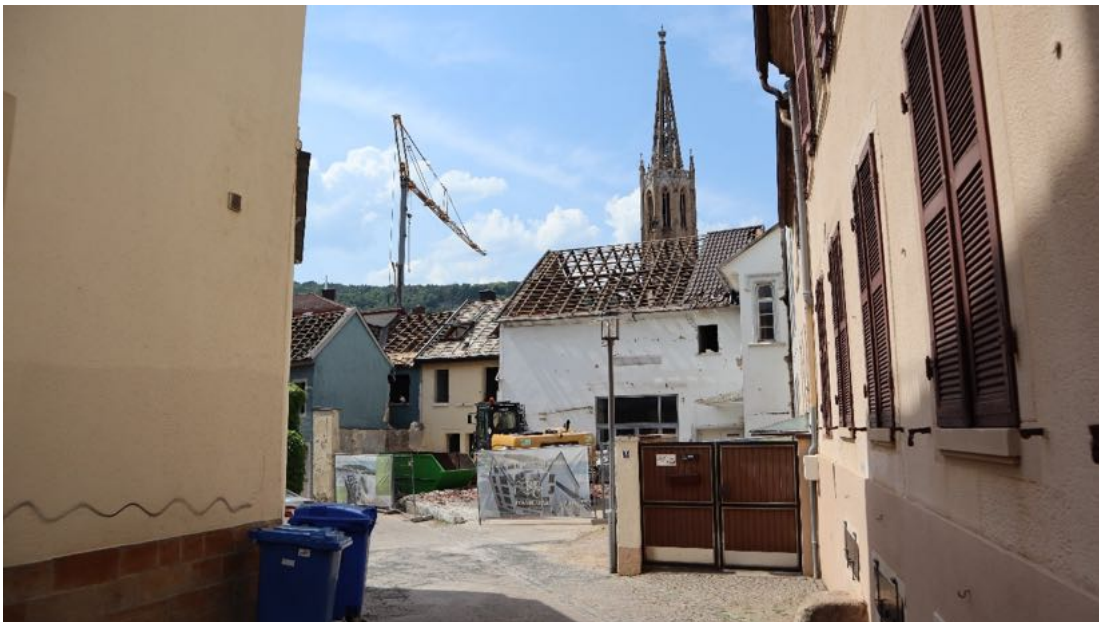
Abb. 66: Schulgasse, Blick in den Straßenverlauf von der Römerstraße aus kommend mit Baustellensituation (Zustand Juni 2021).
