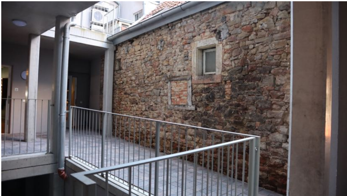
Abb. 43: Hinter Römerplatz 8, Blick auf unverputzte Längsseite des Wohnhauses im Innenhof von Kirchgasse 1.
