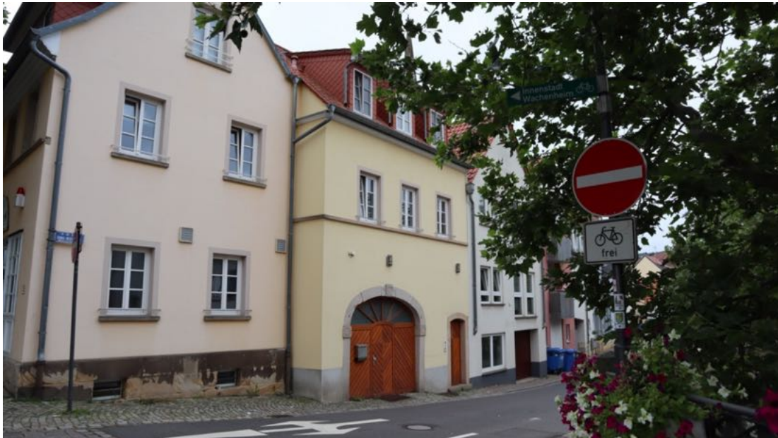
Abb. 91: Weinstraße Nord 19, Ansicht von Norden mit Blick auf die Fassaden der beiden zugehörigen Häuser sowie in den Verlauf der Eichstraße.
