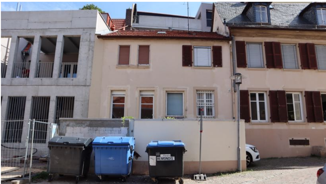
Abb. 42: Hinter Römerplatz 8, Blick von Südwesten, links der Neubau Kirchgasse 1, rechts angrenzend das Einzeldenkmal Römerplatz 8.
