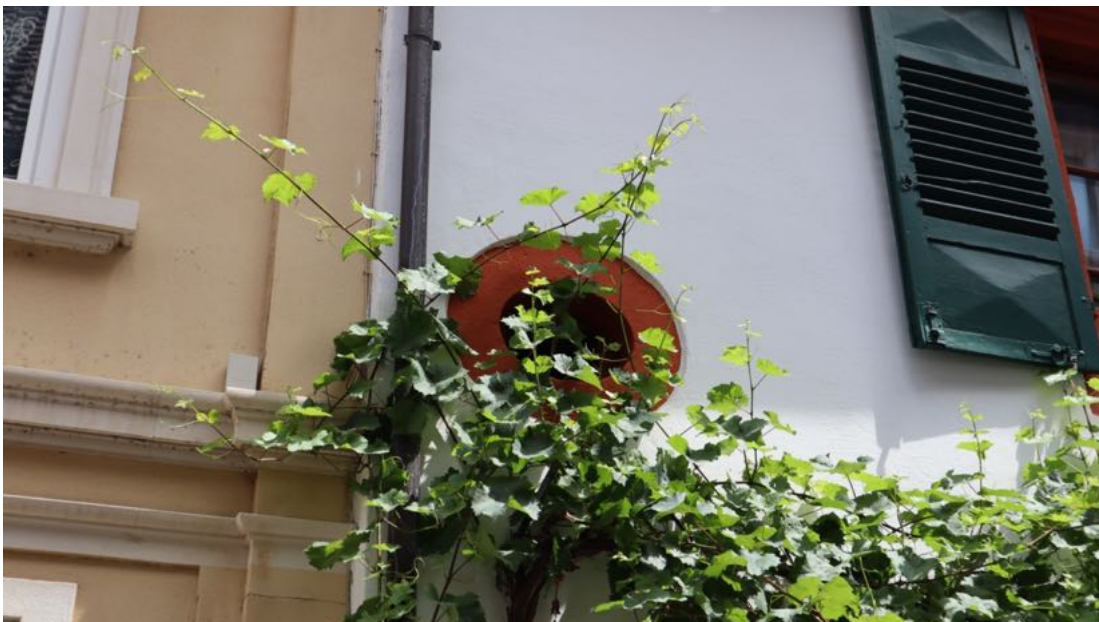
Abb. 18: Kirchgasse 2, Detailaufnahme eines barocken Oculus-Fensters.
