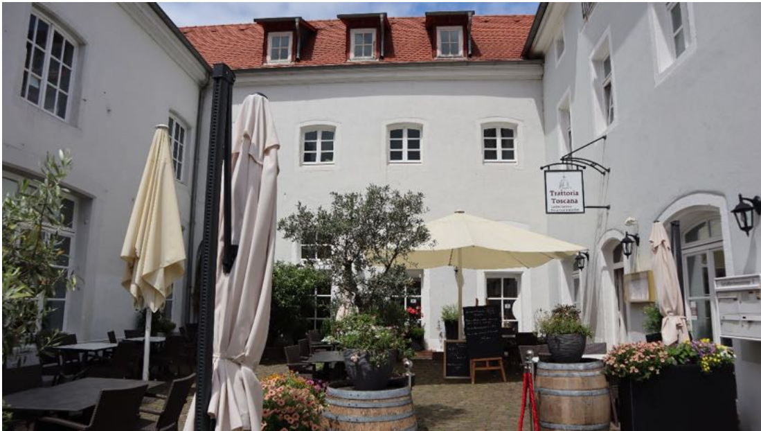
Abb. 63: Schlosskirchenpassage 2, Blick in die Hofsituation mit den beiden angrenzenden Gebäudeteilen (mittlerer Trakt sowie daneben die heutige Nr. 4).
