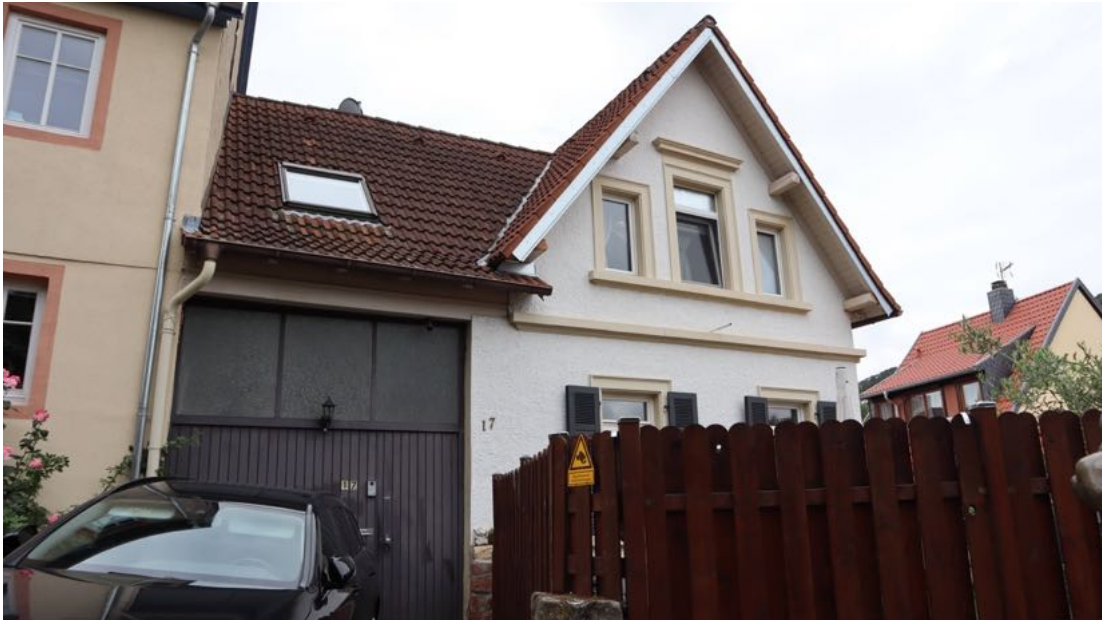
Abb. 35: Kirchgasse 17, Blick von Osten auf Fassade und überbaute Einfahrt, links angeschnitten Haus Nr. 15.
