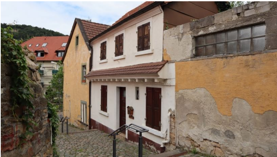
Abb. 36: Kirchgasse 18, Ansicht von Süden, links davon die Giebelwand des Hauses Eichstraße 7.
