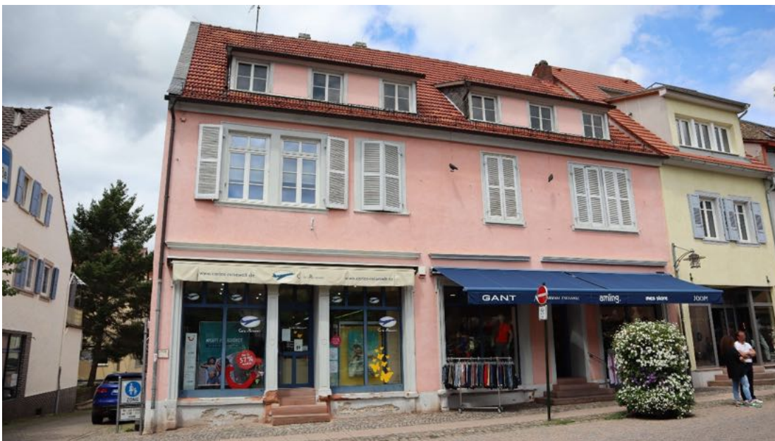
Abb. 54: Römerstraße 12, Ansicht von Süden, links die Rote-Kreuz-Straße.
