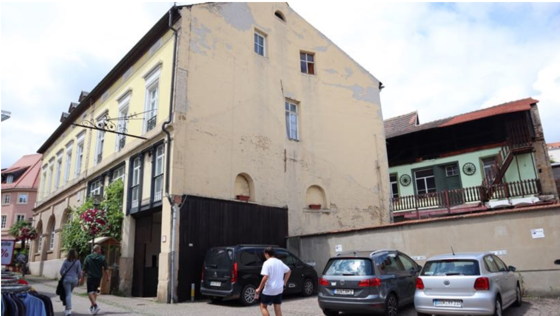
Abb. 40: Römerplatz 2, Blick von Südosten auf Giebelseite sowie rückwärtiges Scheunengebäude.
