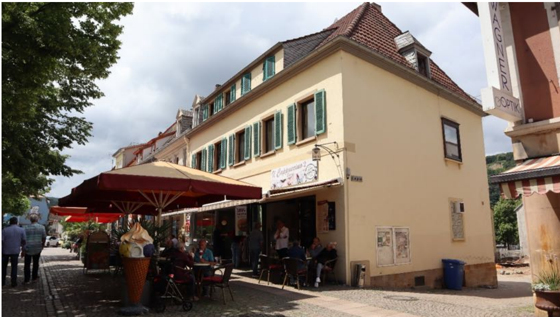
Abb. 49: Römerstraße 2, Ansicht von Nordosten, rechts davon die Einmündung der Schulgasse.
