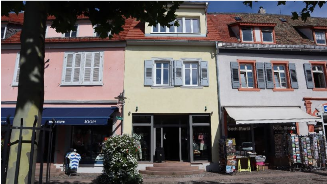
Abb. 53: Römerstraße 10, Ansicht von Süden, links Haus Nr. 12 sowie rechts das Einzeldenkmal 6/8.
