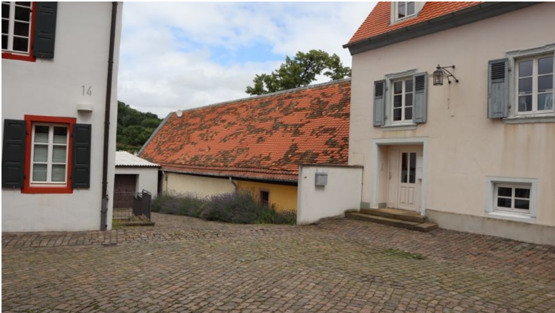
Abb. 89: Hinter Weinstraße Nord 13, Ansicht von Süden, rechts daneben das Haus Kirchgasse 12 a.
