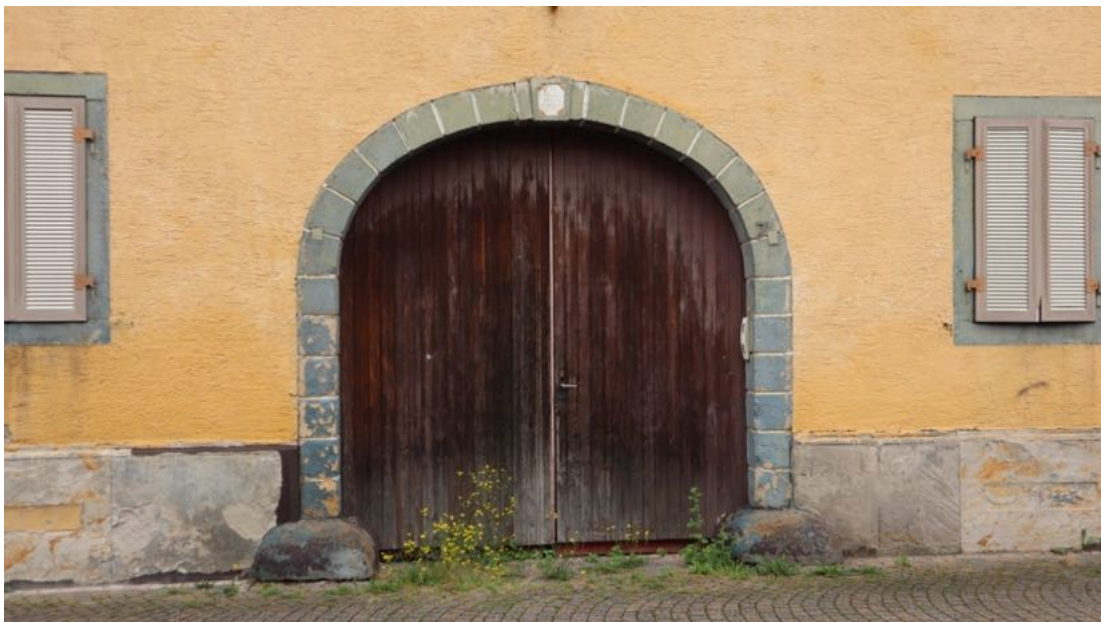
Abb. 6: Eichstraße 7, Detailaufnahme Torbogen, bez. 1769.
