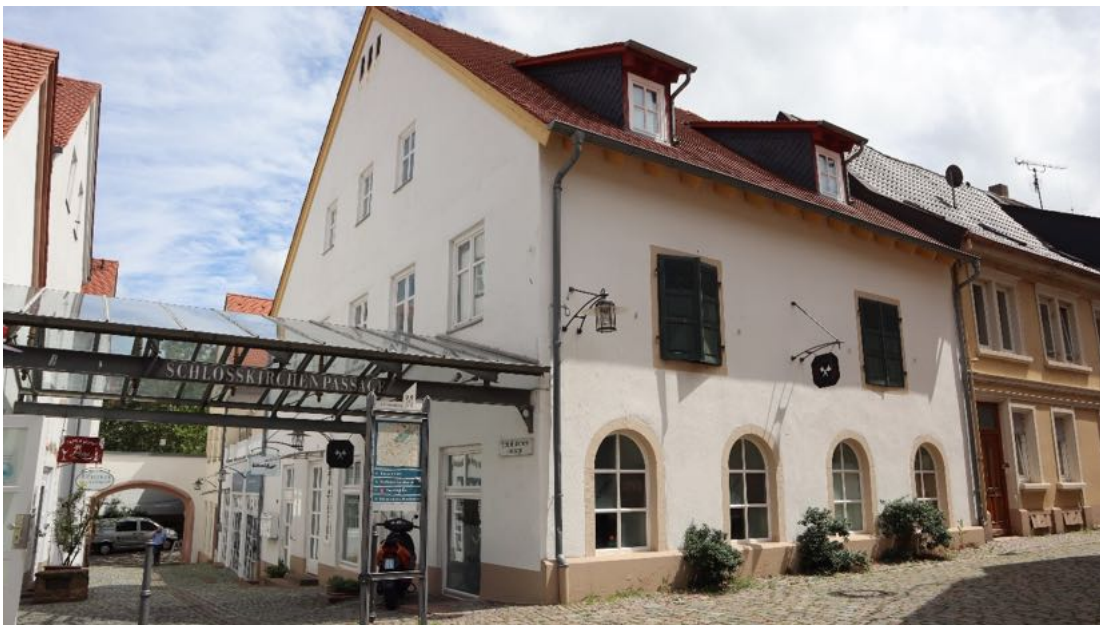
Abb. 64: Schosskirchenpassage 3, Blick von Westen auf die erhaltene, traufständige Fassade zur Kirchgasse hin.
