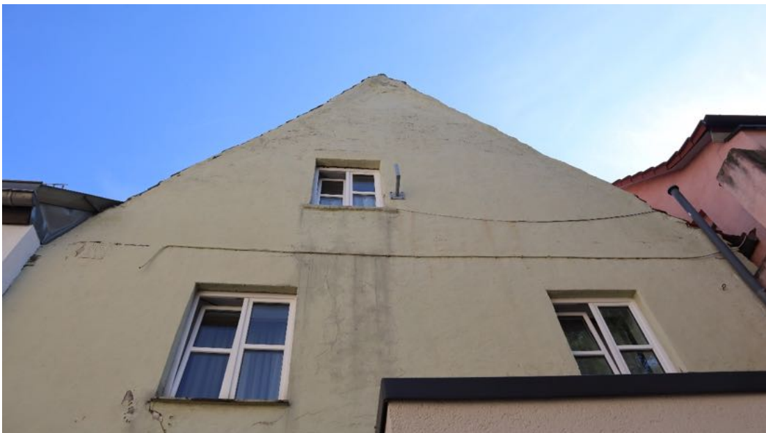
Abb. 72: Schulgasse 3, Detailaufnahme des älteren Giebels in der Rote-Kreuz-Straße.
