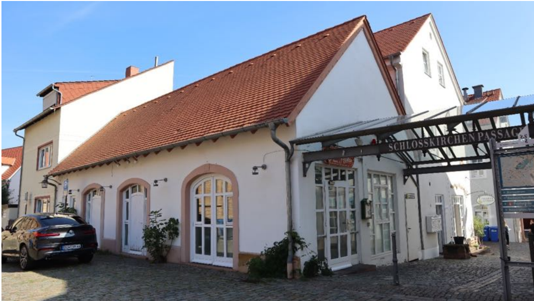
Abb. 65: Schlosskirchenpassage 6, Ansicht von Süden.
