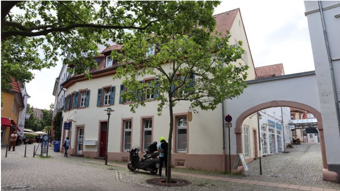
Abb. 59: Schlosskirchenpassage 1, Ansicht von Nordosten, rechts der Torbogen von Nr. 2 mit Blick in den dahinterliegenden Passagenverlauf.
