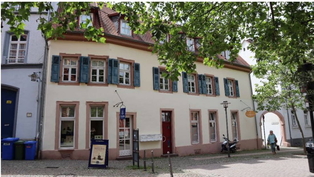
Abb. 60: Schlosskirchenpassage 1, Ansicht von Osten auf die über Eck verlaufende Fassade.
