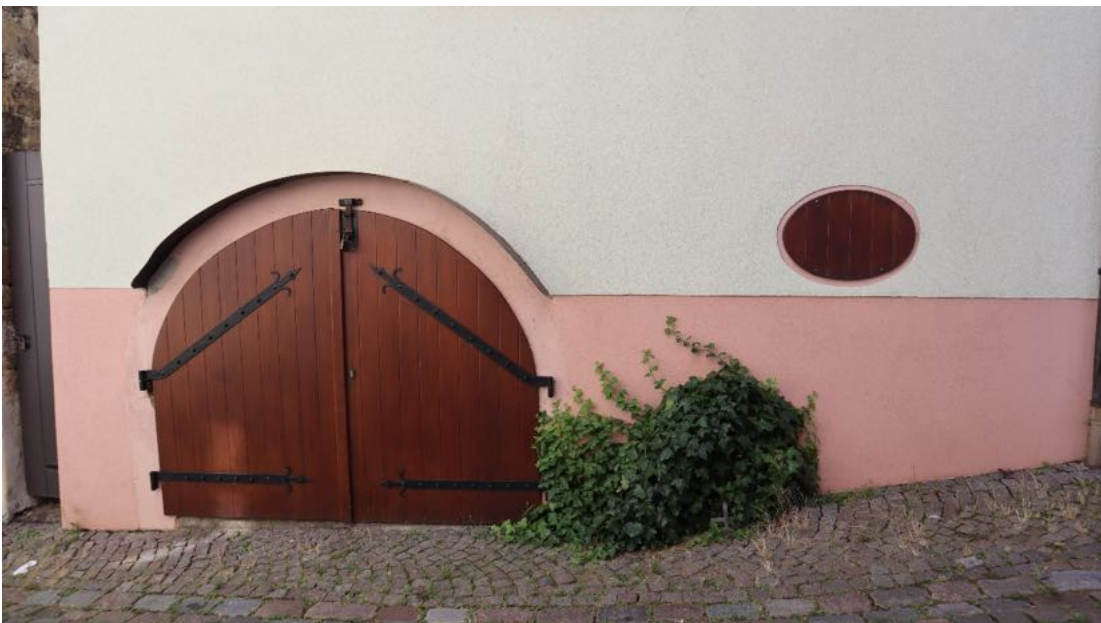
Abb. 26: Kirchgasse 10, Detailansicht des rundbogigen Kellerabgangs und des querovalen Kellerfensters.
