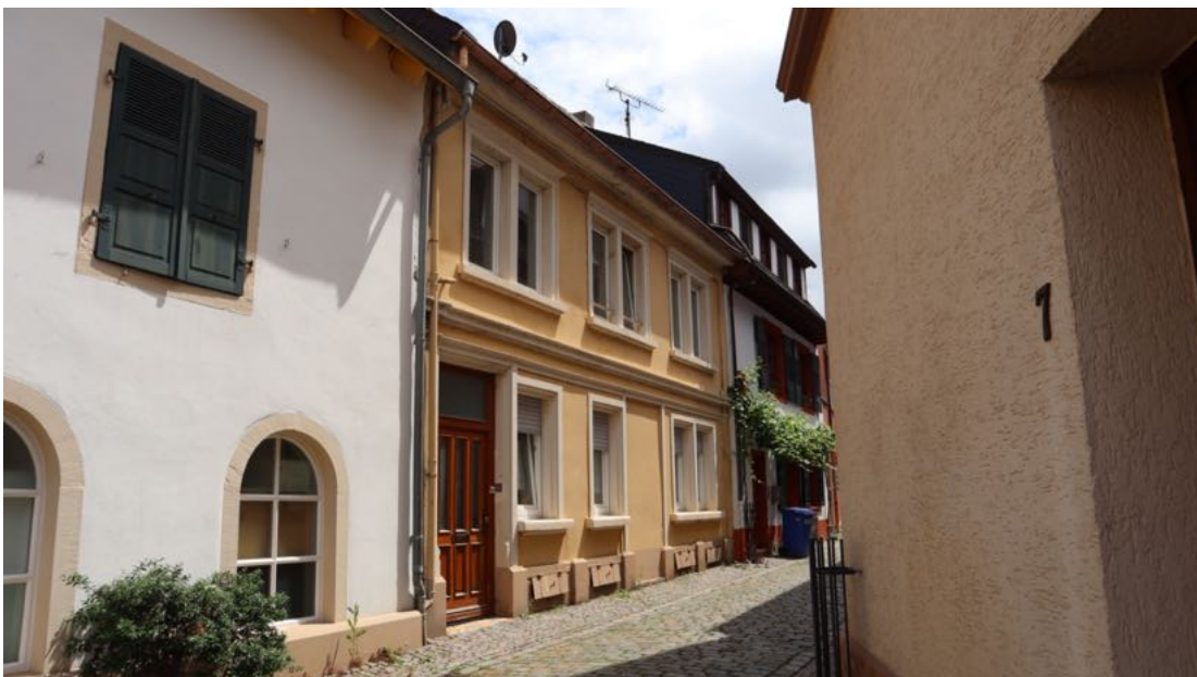
Abb. 20: Kirchgasse 4, Blick Westen, links die Fassade von Haus Nr. 3.
