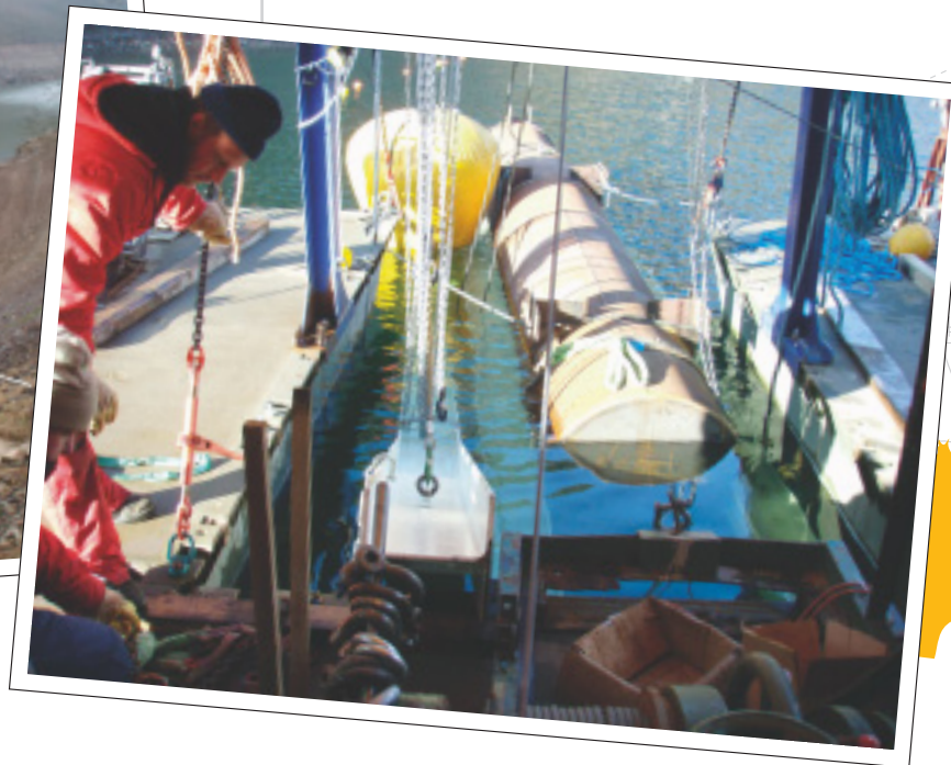
Arbeitsponton der Taucher zur Montage des Entnahmearms auf abgesenkter Talsperre
