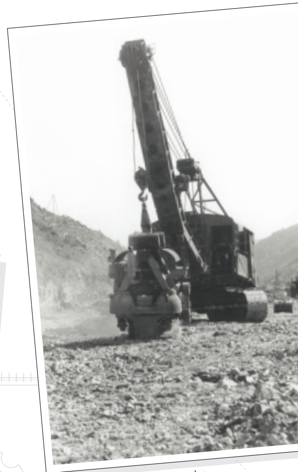
Großrüttler zur Verdichtung der Dammschüttmassen
