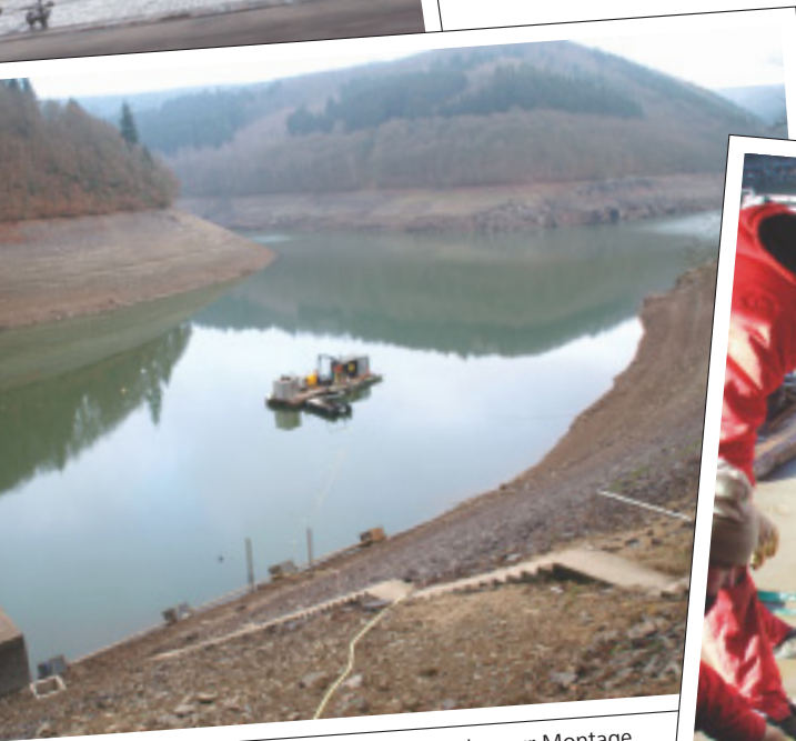
Arbeitsponton der Taucher zur Montage des Entnahmearms auf abgesenkter Talsperre
