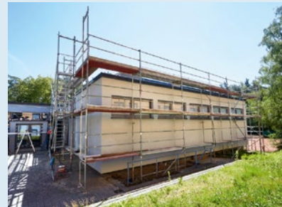
Energetische Sanierung: Sporthalle des Heinrich-Heine-Gymnasiums in Kaiserslautern
