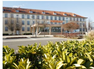
Neuer Behördenstandort: Das frühere Verwaltungsgebäude der Hornbach-Gruppe
