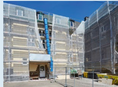
Fassaden- und Dachsanierung Amtsgericht Lahnstein
