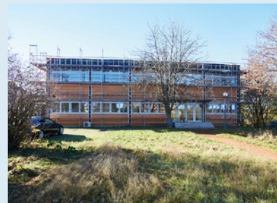
Energetische Sanierung: Laborgebäude der Forschungsanstalt für Waldökologie und Forstwirtschaft in Trippstadt
